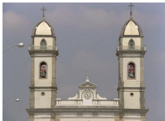
12.2 Continuidade do plano anterior. Novamente utilizando o zoom , a câmera de Reichenbach dirige à atenção, se aproximando em movimento das torres da igreja, símbolos da presença e dos valores do colonizador, se elevando acima da natureza e da "selvageria".
