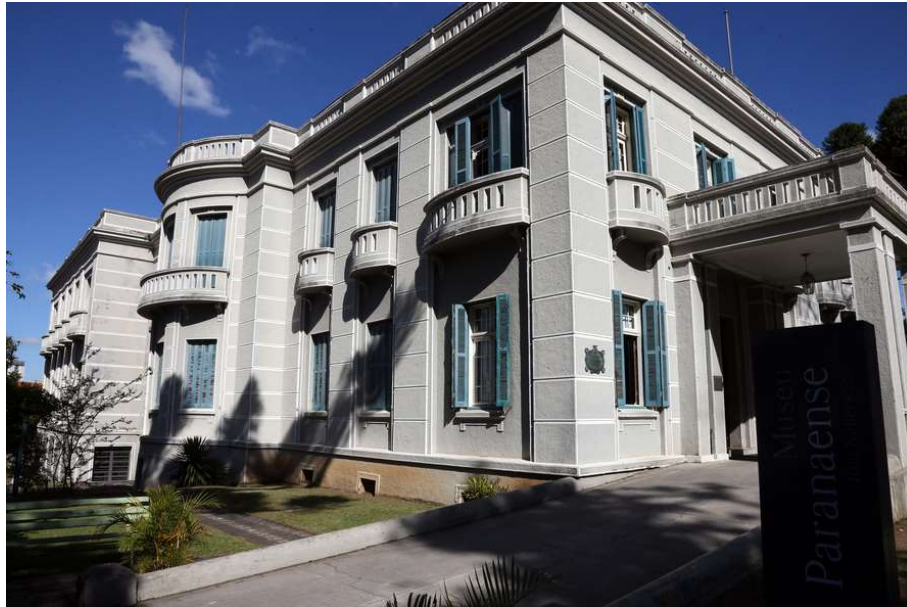
FIGURA 2 – ANEXO PRINCIPAL PATRIMONIAL DO MUPA
