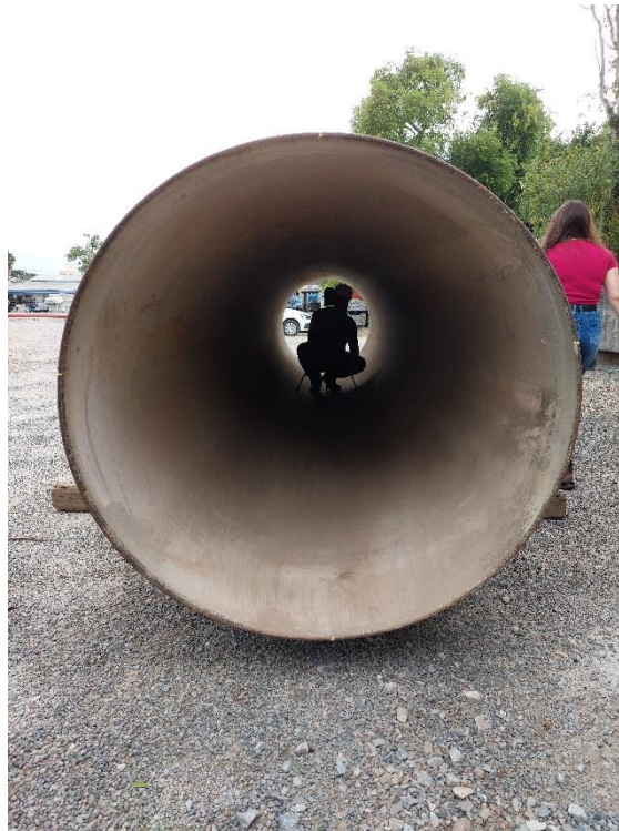
Figura 65 - Laser Scanner Instalado em uma posição internamente à tubulação, fazendo varredura terrestre
