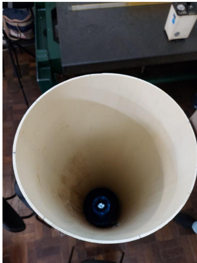
Figura 21 - Discrepância e irregularidades nas espessuras na Tubulação
