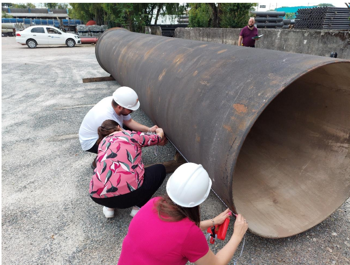
Figura 52 - Realizando o posicionamento das seções na tubulação DN1200
