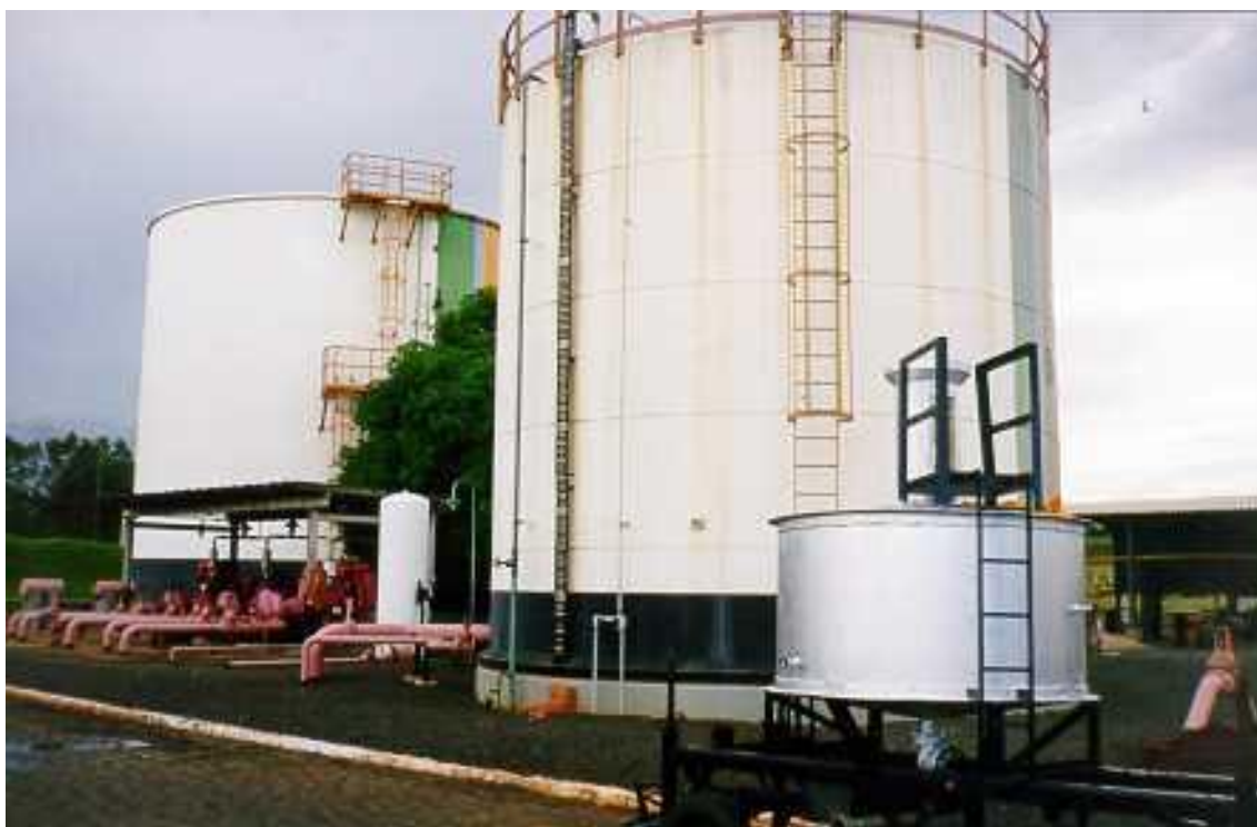
Figura 6 - Verificação de Arqueamento de Tanques
