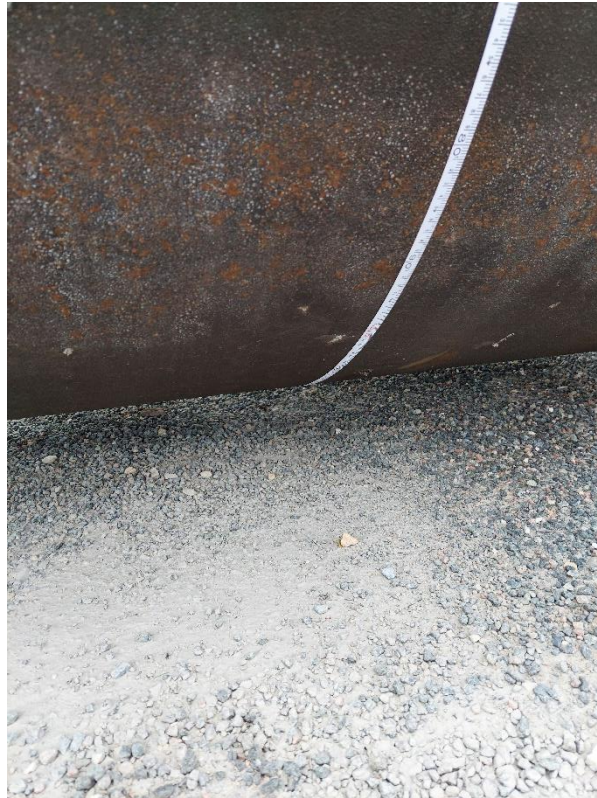
Figura 59 - Fita de arqueamento envolvendo a tubulação – Método de Arqueamento
