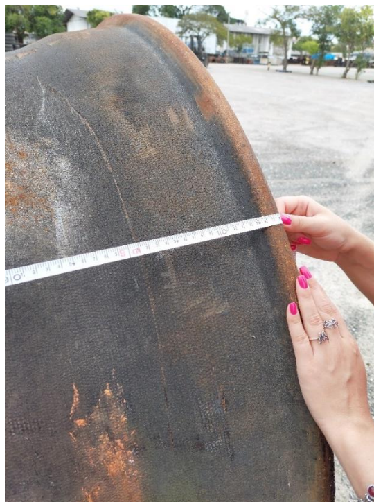
Figura 50 - Realizando-se a medição da tubulação DN1200 na lateral com a bolsa
