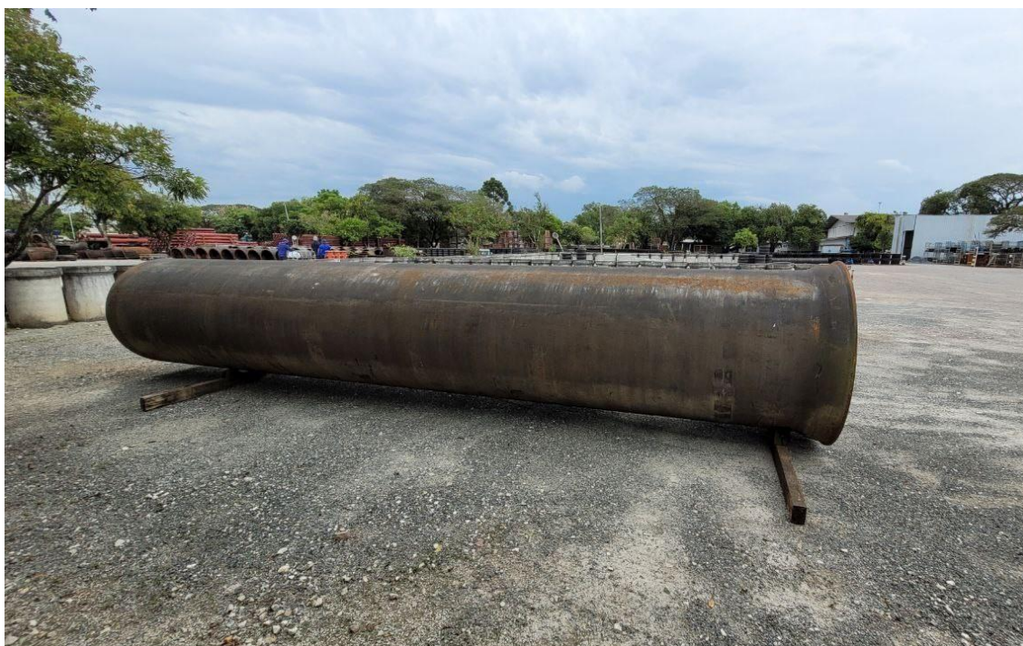
Figura 48 - Tubulação de água DN1200 na sede da SANEPAR
