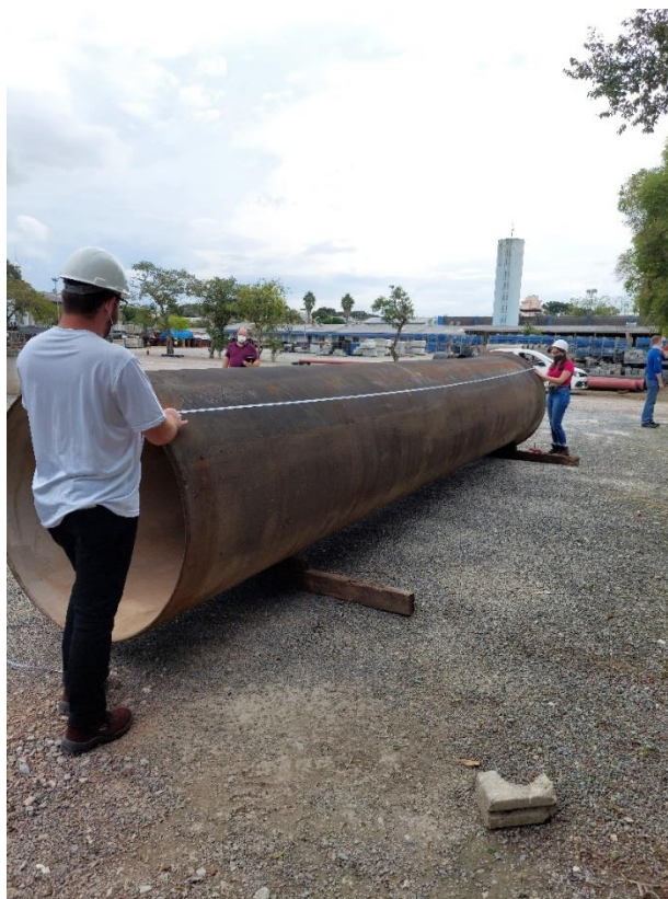
Figura 51 - Mensurando o comprimento total da tubulação DN1200
