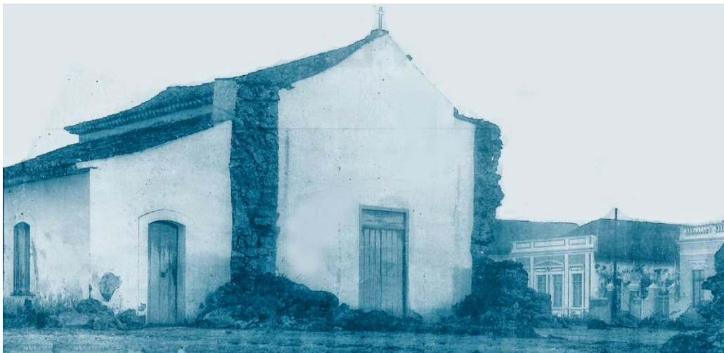
Figura 2 - Vista frontal da capela-mor (foto antiga 1). Fonte: Acervo Casa da Memória, Curitiba.
