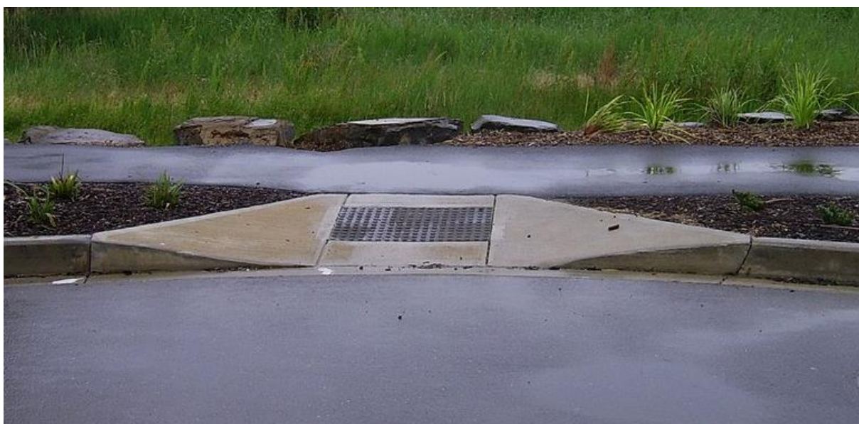
Figura 3 - Exemplo de rampa de acesso
