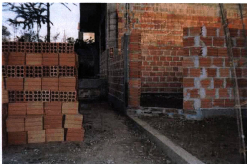
FOTO 7 – VISTA PARCIAL DO CANTEIRO DE OBRAS
