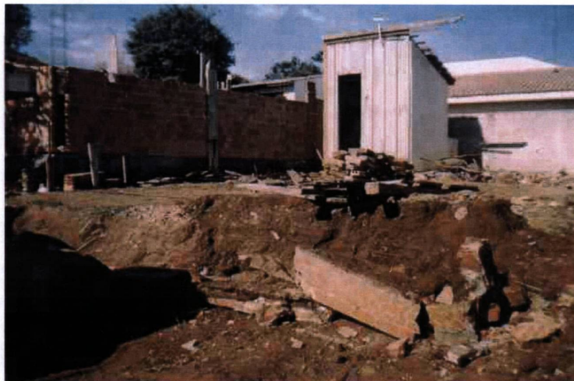
FOTO 1 – INSTALAÇÕES SANITÁRIAS EXISTENTES
