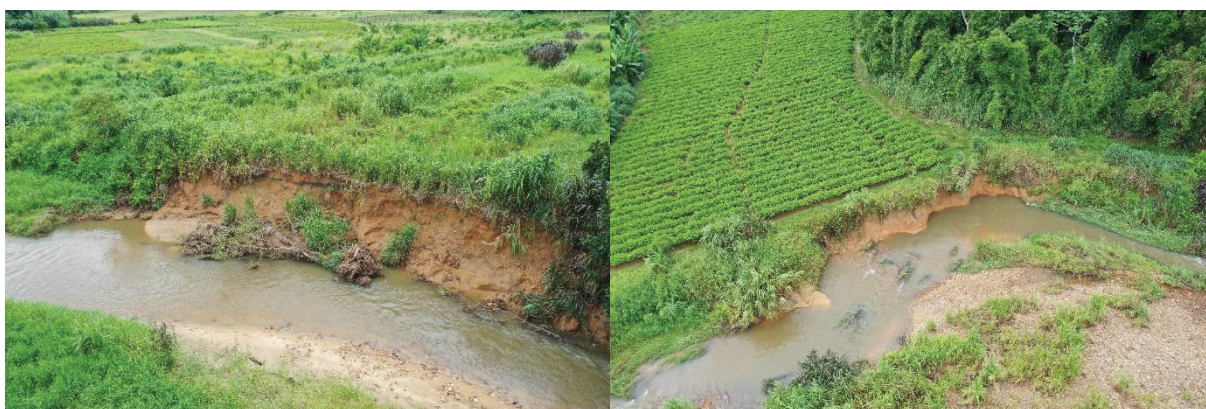
Figura 8.23 – Erosão do dique marginal antrópico pelo rio Jacareí. Sedimento inconsolidado movimentado pelo evento de 2011 disponível para transporte fluvial.
