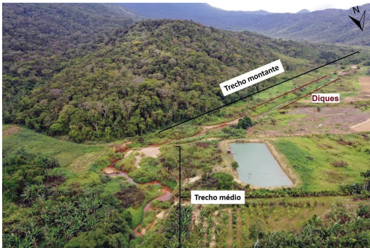
Figura 7.7 – Visualização do trecho 1, com seus diques marginais, e início do trecho 2, com o ponto de maior migração lateral do canal. Registro em 21/10/2020.
