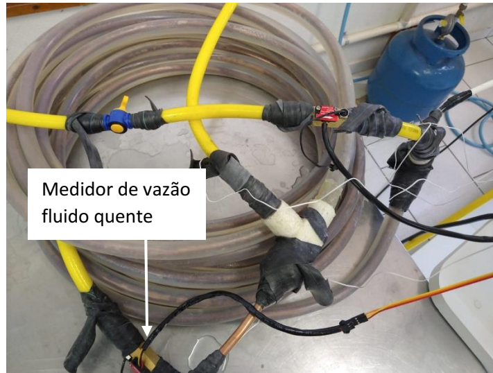
FIGURA A.2 – MEDIDORES DE VAZÃO ACOPLADOS NO TROCADOR DE CALOR.
