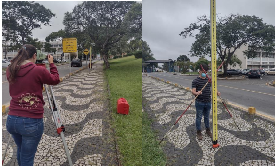
Figura11 REALIZAÇÃO DO NIVELAMENTO GEOMÉTRICO EM CAMPO
