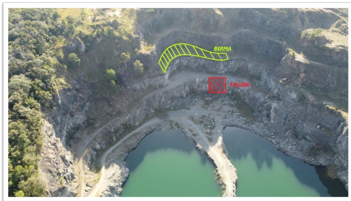
FIGURA 29 - CARACTERIZAÇÃO DAS BERMAS E TALUDES
