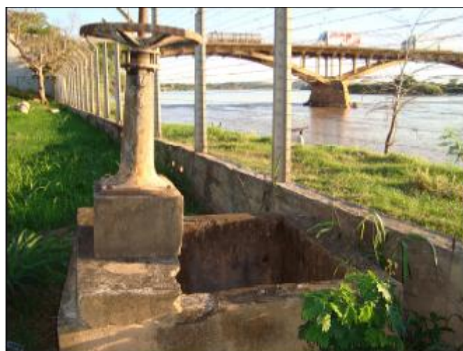
Figura 28: Sistema de captação da água na estação Vila Isa Fonte: PMSB GV, 2015
