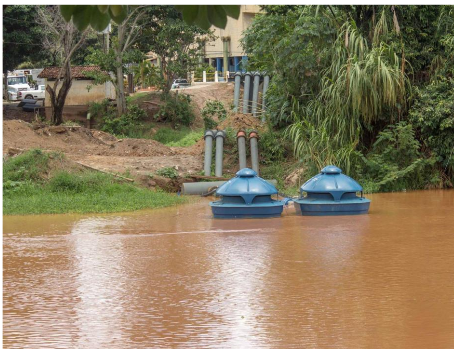
Figura 56: Bombas flutuantes para captação de água bruta na ETA Central Fonte: Portal Confluências, 2016
