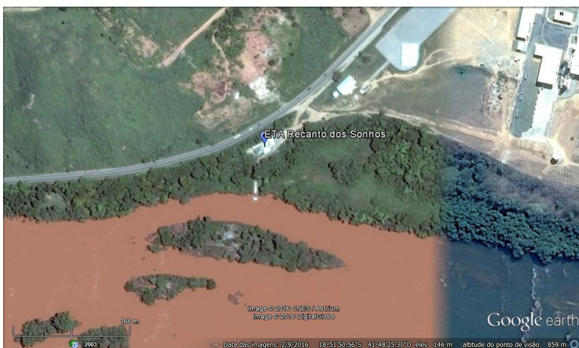
Figura 32: Localização da ETA Recanto dos Sonhos
