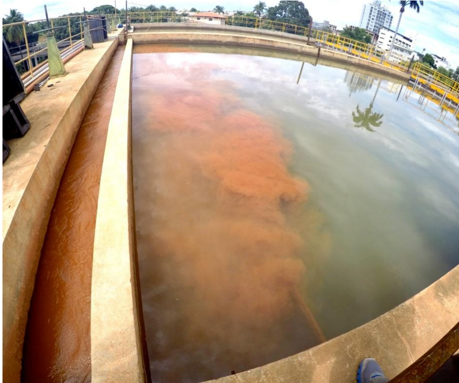
Figura 64: Tábua de madeira instalada na primeira câmara de um dos módulos de decantação
