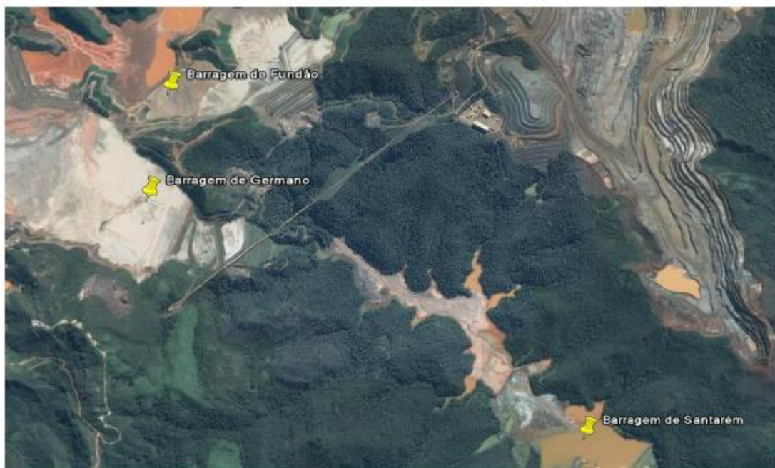
Figura 36: Localização das três barragens da unidade de Germano Fonte: Google Earth, IBAMA, 2016
