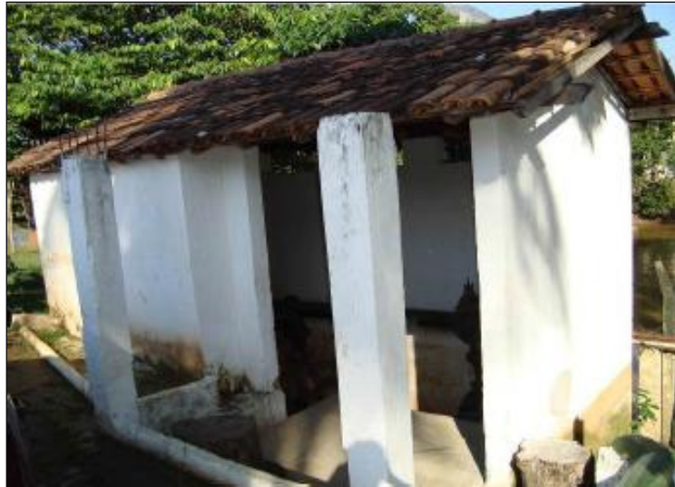
Figura 25: Captação Auxiliar da ETA Central Fonte: SAAE/GV, 2013
