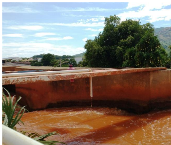
Figura 61: Dosagem de sulfato de alumínio na Calha Parshal Fonte: Acervo Próprio, 2016
