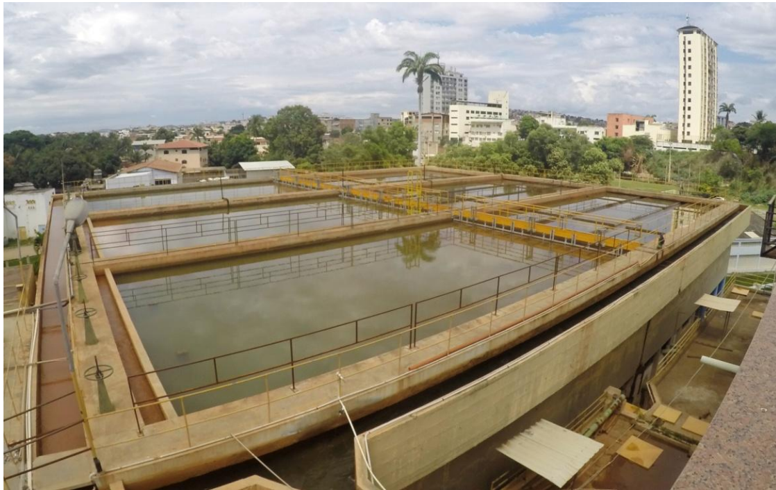
Figura 63: Vista dos 3 módulos de decantação da ETA Central Fonte: Acervo Próprio, 2016
