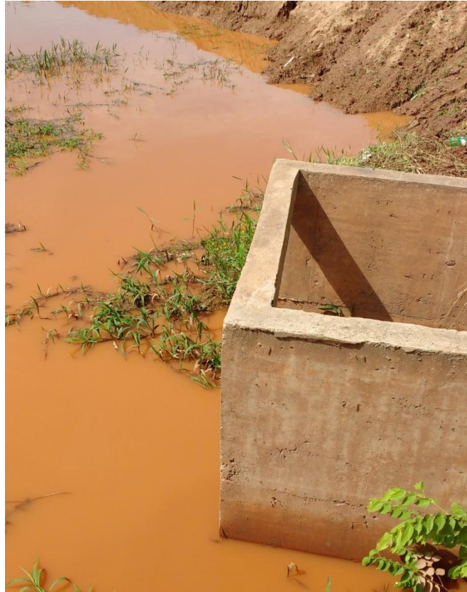
Figura 57: Captação Principal da ETA Central Fonte: Acervo Próprio, 2016
