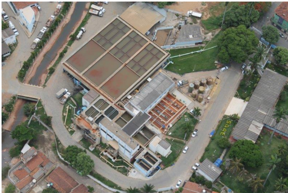
Figura 22: Visão geral da ETA Central Fonte: ANA, 2016
