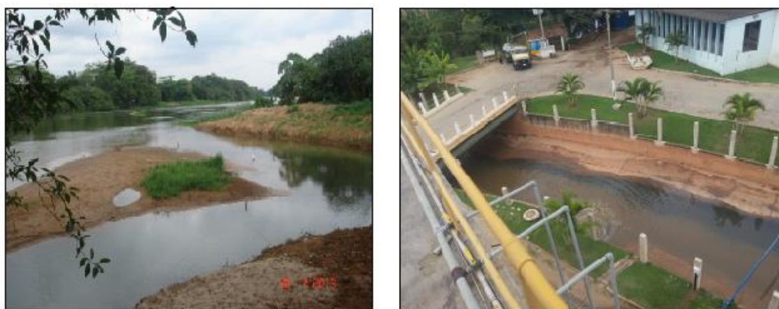
Figura 26: Problemas identificados na ETA Central (formação de banco de areia e disposição do lodo)
