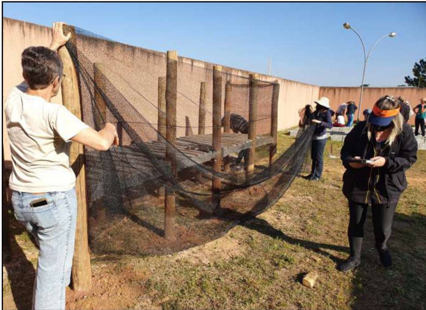
Figura 11 – Instalação da Tela de Proteção
