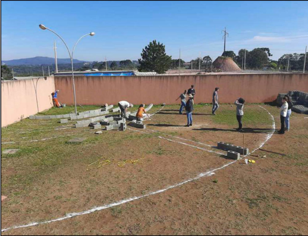
Figura 13 – Colocação dos primeiros blocos de cimento
