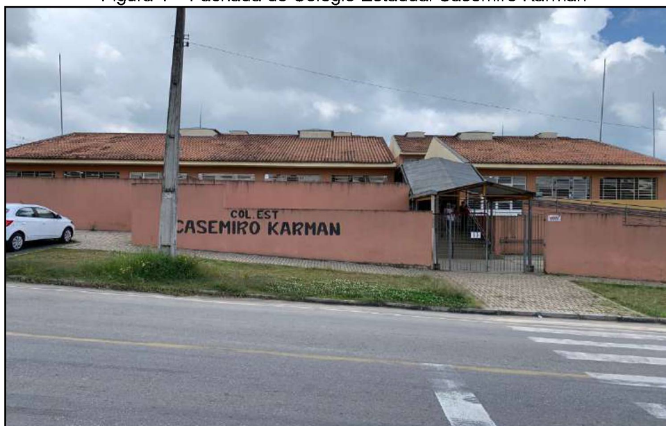
Figura 1 – Fachada do Colégio Estadual Casemiro Karman
