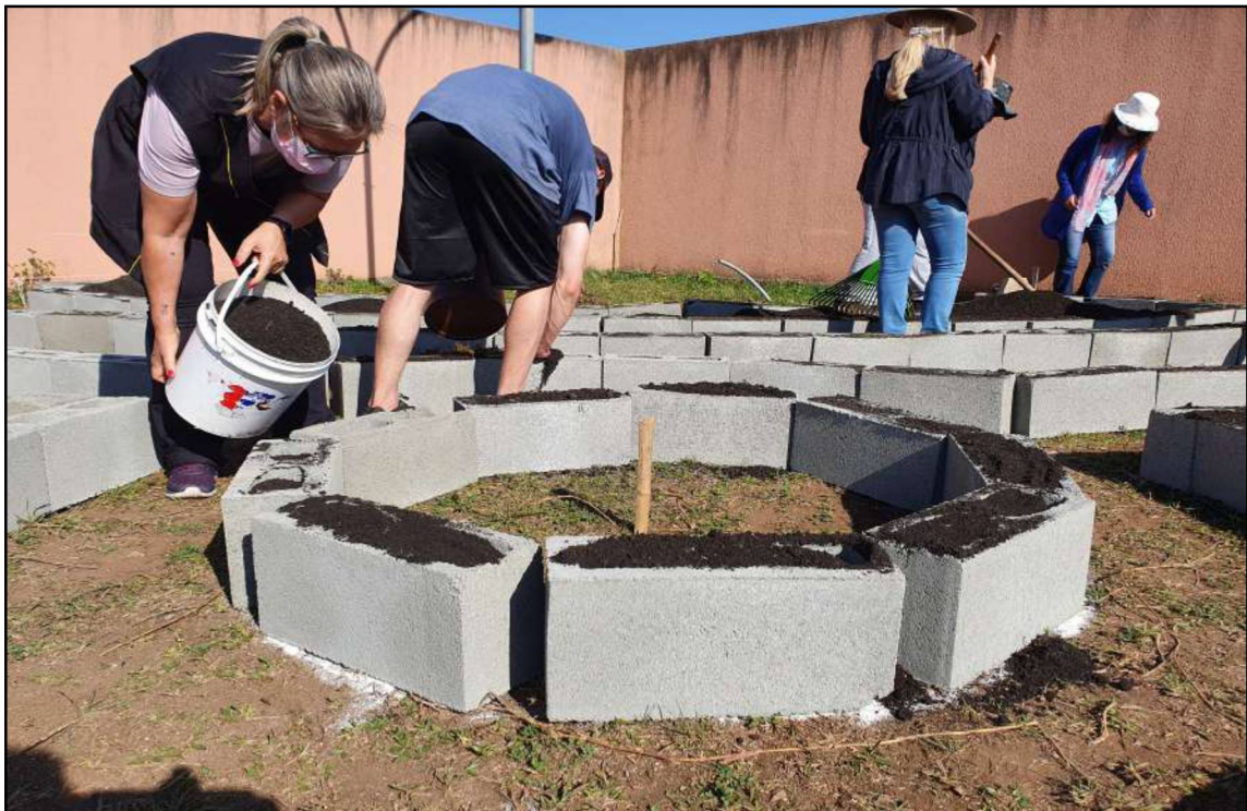
Figura 17 – A terra é despejada no canteiro
