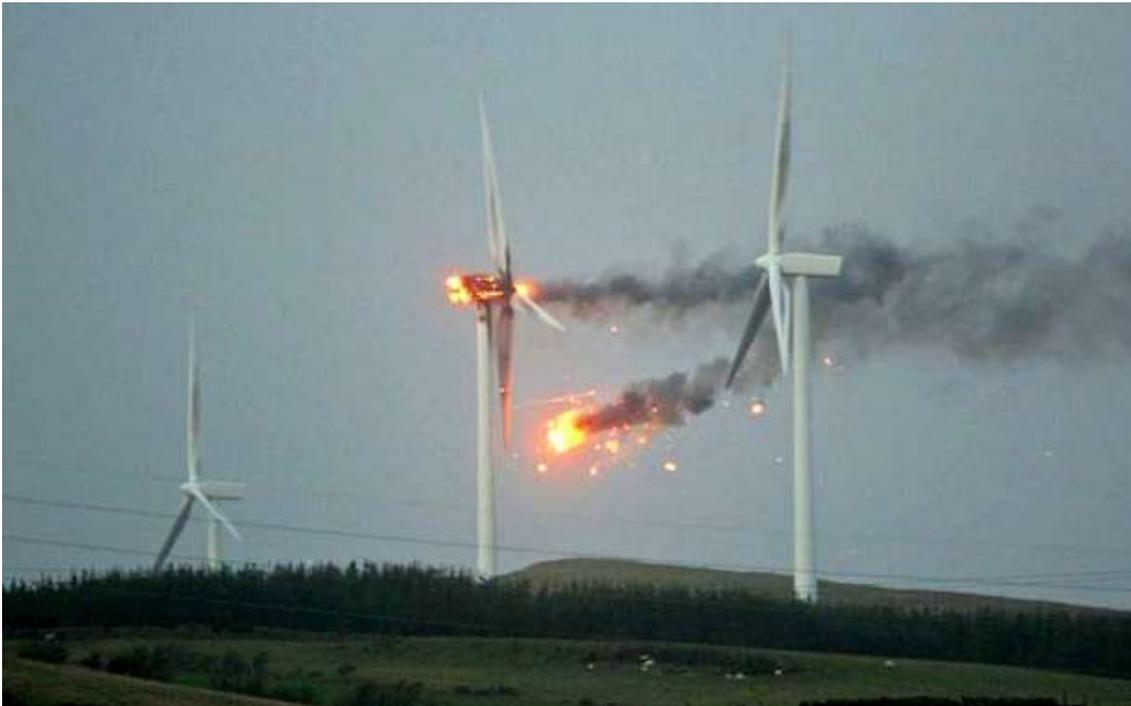
Figura 10: Explosão de uma turbina durante tempestade na Escócia.
