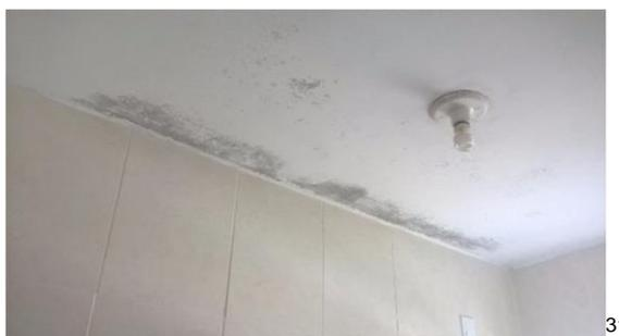
Figura 21 Vazamento de água que gera umidade
