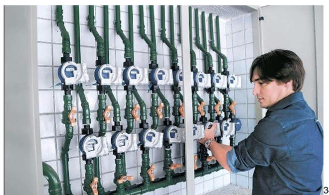
Figura 23 Hidrômetro individual
