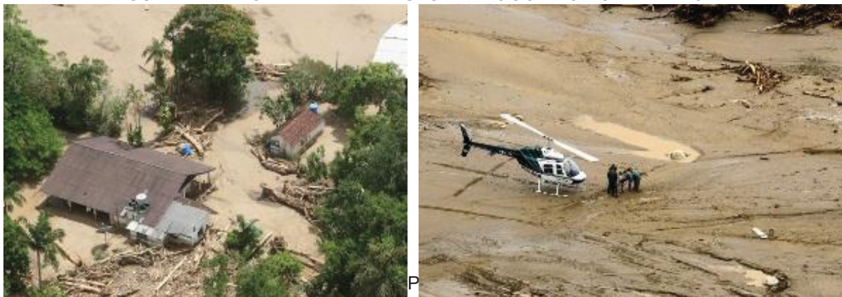
FIGURA 1 - DANOS A INFRAESTRUTURAS LOGO APÓS OS EVENTOS.
