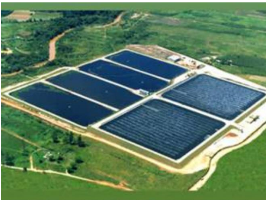
Figura 7 - Lagoa de Estabilização. Fonte: Inteiro Ambiente.
