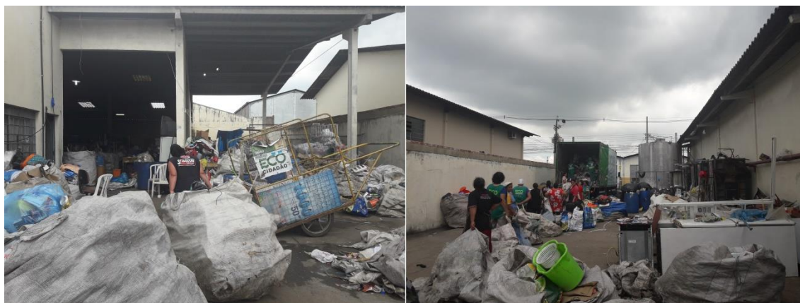
Figura 18: Galpão da Associação dos Catadores de Materiais Recicláveis Unidos do Bairro
