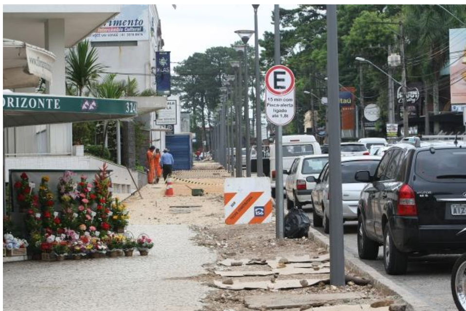
FIGURA 05 - AVENIDA DO BATEL PASSANDO POR OBRAS DE REFORMA. FONTE: PREFEITURA MUNICIPAL DE CURITIBA, 2013.
