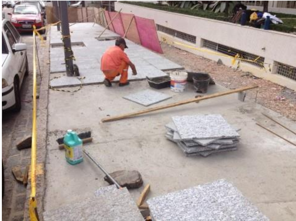
FIGURA 06 - COLOCAÇÃO DO NOVO CALÇAMENTO NA AVENIDA DO BATEL. FONTE: PREFEITURA MUNICIPAL DE CURITIBA, 2013.
