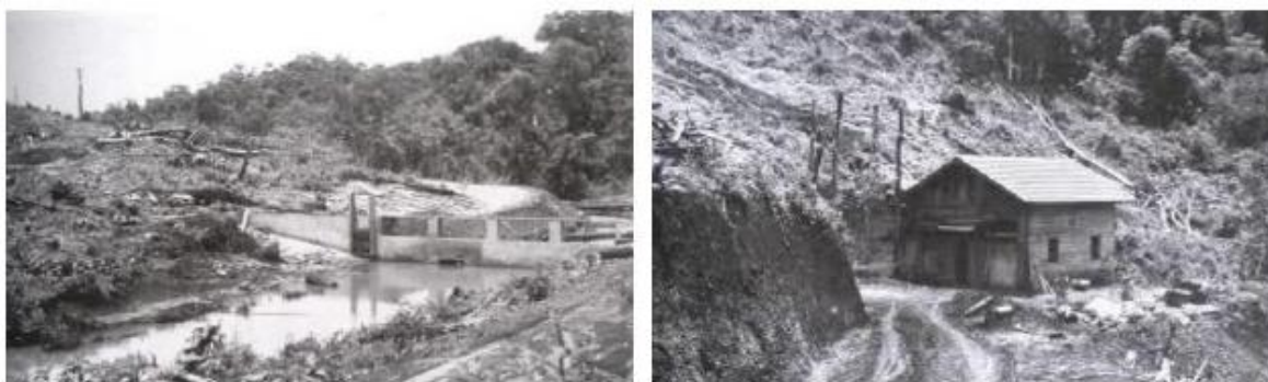
FIGURA 10: CONSTRUÇÃO DA USINA CAMBÉZINHO E A BARRAGEM E CASA DE MÁQUINAS. FONTE: (VIEIRA, 2016).
