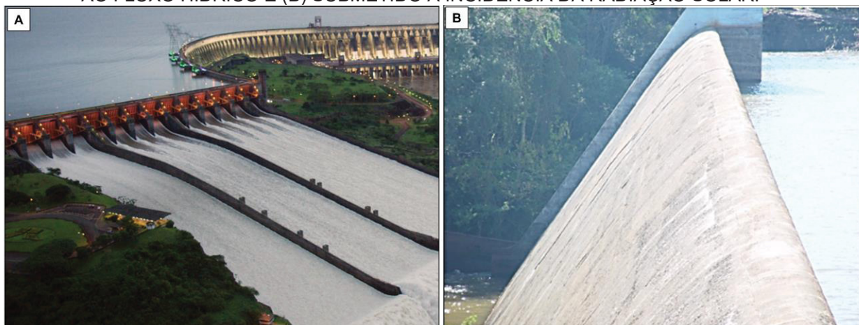
FIGURA 02 - CALHA DE VERTEDOIRO EM DUAS SITUAÇÕES: (A) VERTEDOIRO SUBMETIDO AO FLUXO HÍDRICO E (B) SUBMETIDO À INCIDÊNCIA DA RADIAÇÃO SOLAR.
