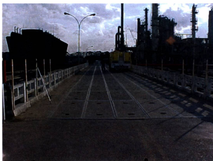
FIGURA 6.6 – VISTA FRONTAL PONTE AA
