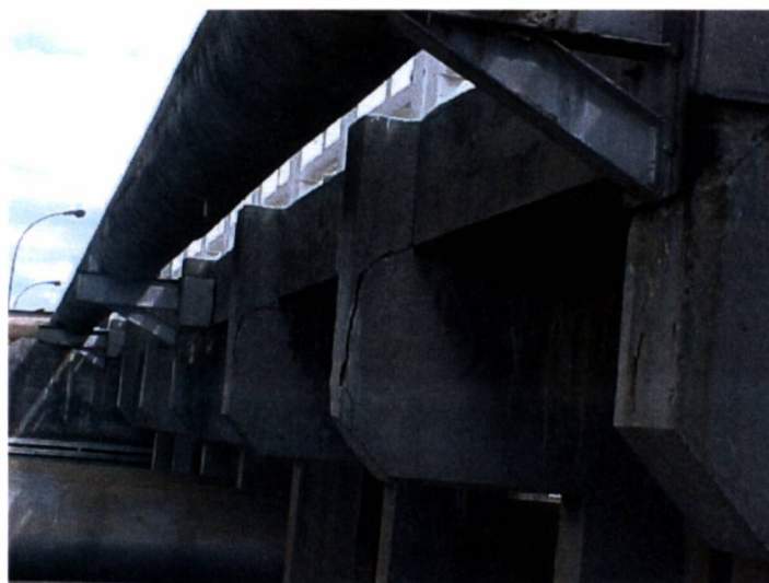
FIGURA 6.5 – VISTA DA MESO ESTRUTURA DAS PONTES
