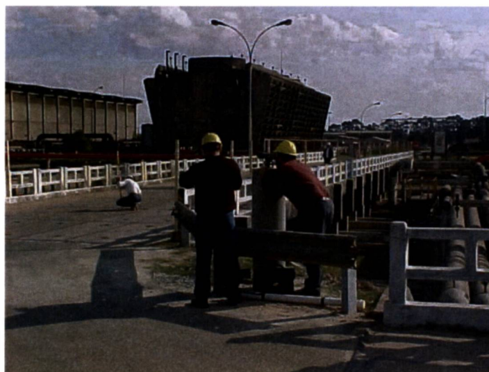
FIGURA 6.2. - VISTA LATERAL DA PONTE AA
