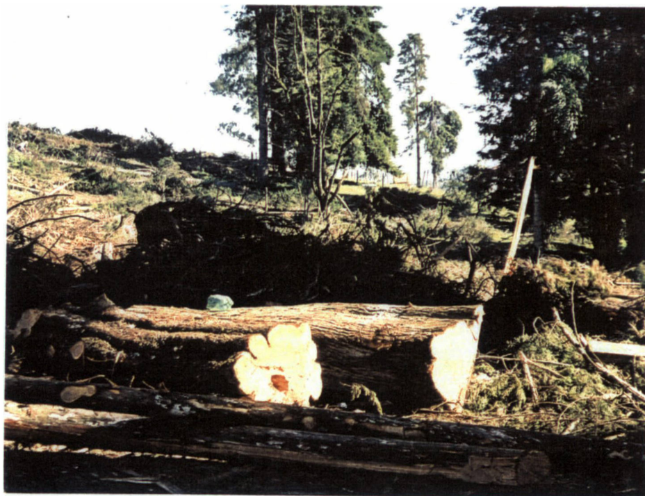
FOTO 5 – CORTE E RETIRADA DE ÁRVORES - LOTEAMENTO ALPHAVILLE PINHEIROS
