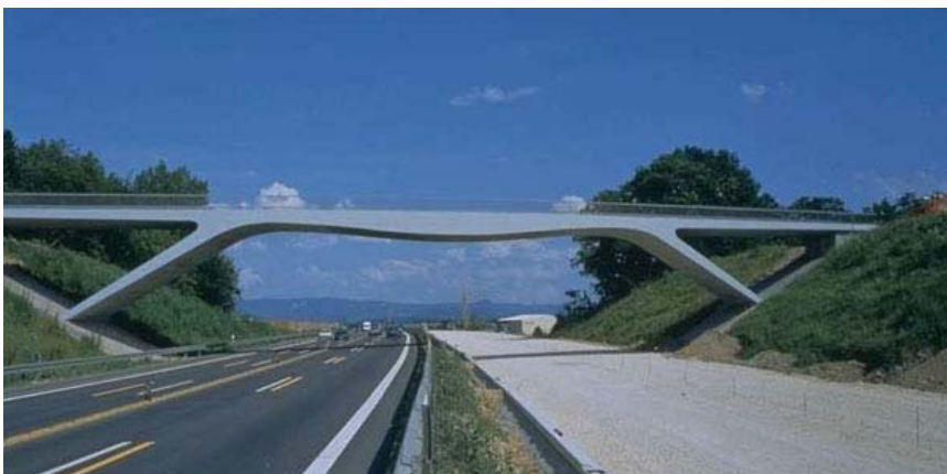
FOTO 3 PUENTE EN PÓRTICO
