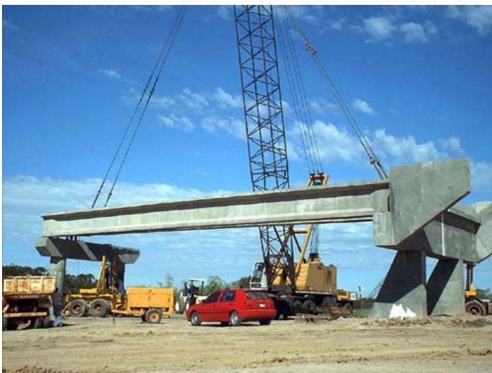
FOTO 17 GRÚA DE IZAJE DE 1500 KN DE CAPACIDAD
