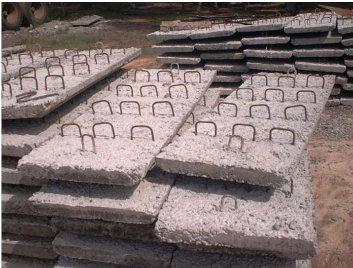
FOTO 16 LOSETAS PREFABRICADAS UTILIZADAS COMO ENCOFRADO DE LOSA
