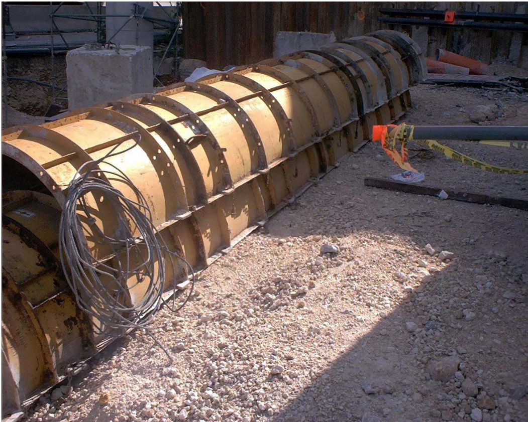
FOTO 9 ENCOFRADOS METÁLICOS UTILIZADOS EN PILARES
