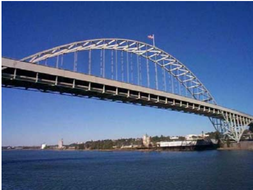
FOTO 7 PUENTE EN VIGA SOPORTADA POR ARCO
