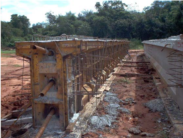
FOTO 13 ENCOFRADO METÁLICO DE VIGAS DE 24 M.
