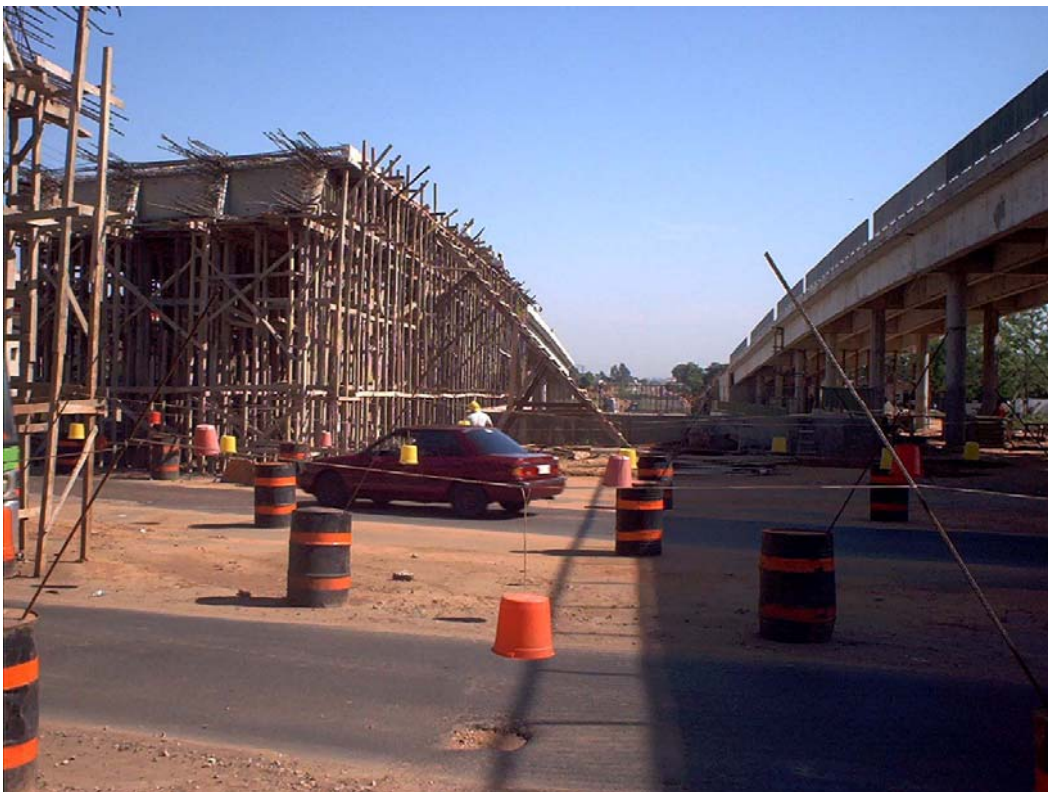
FOTO 10 ENCOFRADO PREPARADO PARA DOS TRAMOS, EN EL LADO IZQUIERDO
