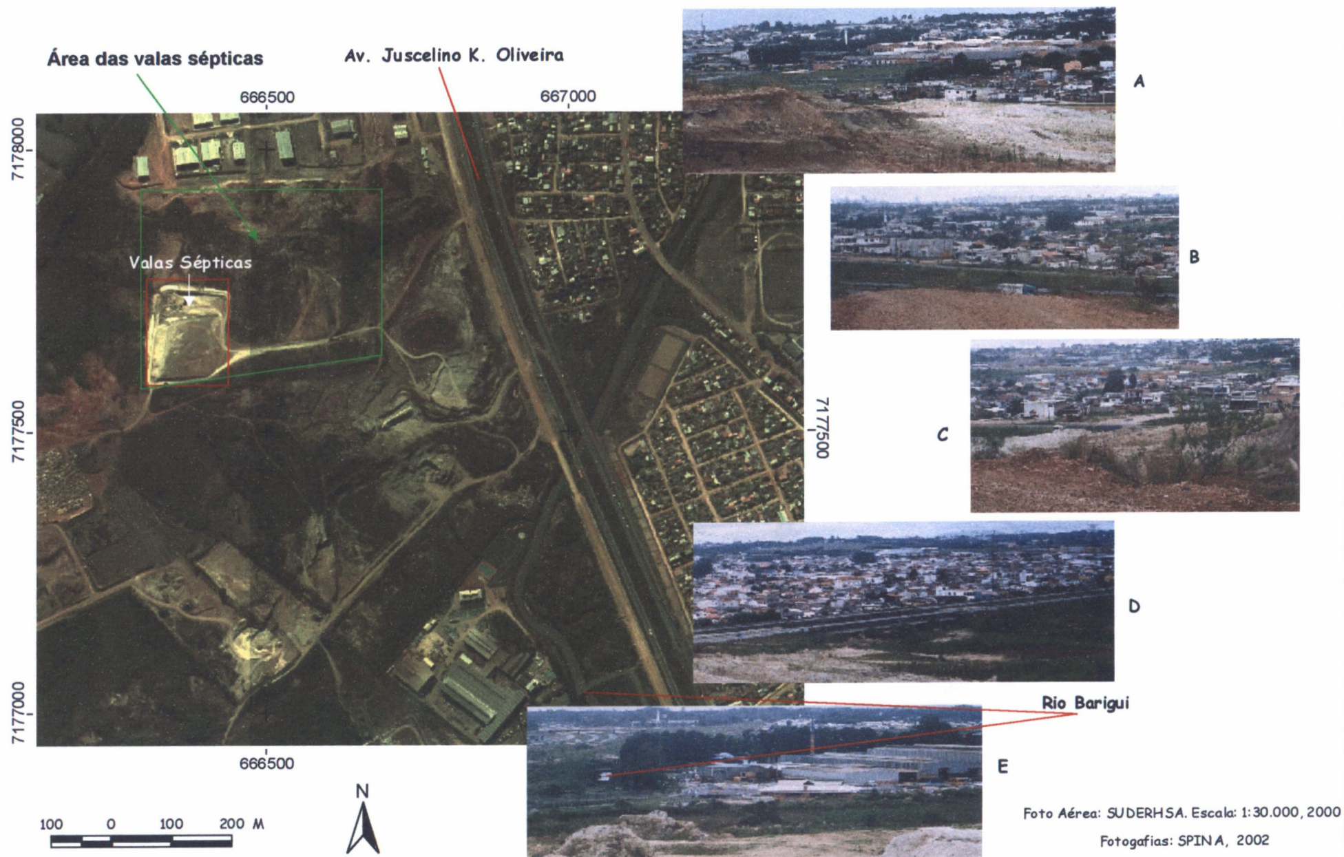
Figura 07 - FOTO AÉREA DAS VALAS SÉPTICAS E ENTORNO
