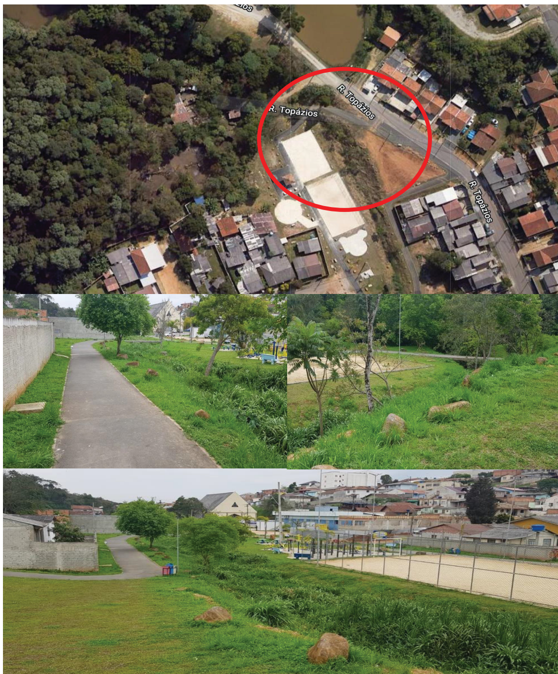
Figura 15 – Área de Intervenção (AI4) na Rua Topázio
