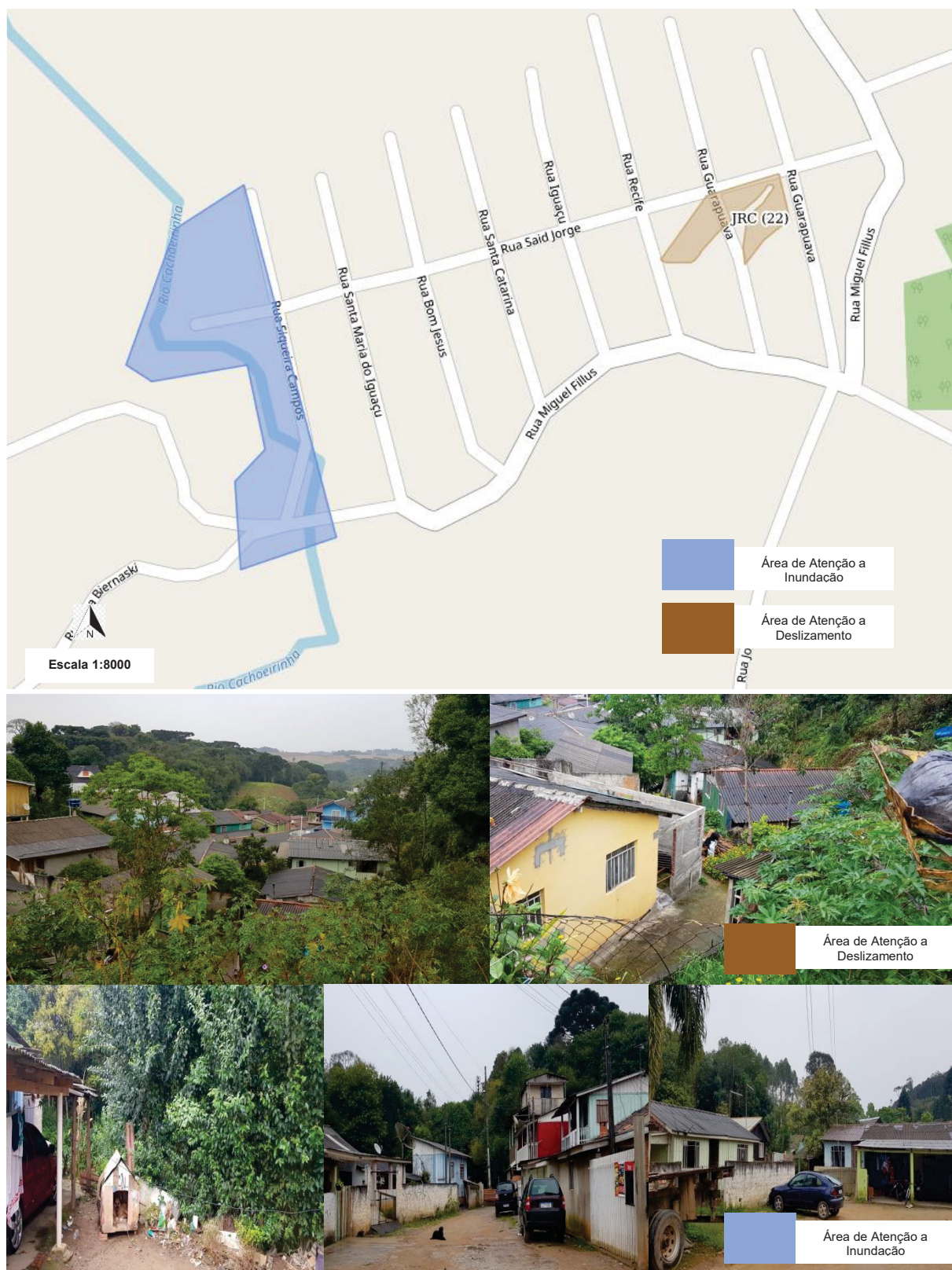
Figura 22 – Áreas de atenção a deslizamentos e inundações no Jardim Bom Pastor
