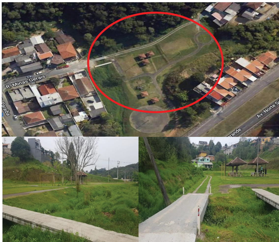
Figura 12 – Área de Intervenção (AI1) na Rua Minas Gerais
