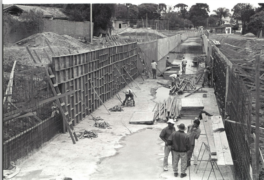
Figura 7 - Obras da canalização na região norte de Curitiba
