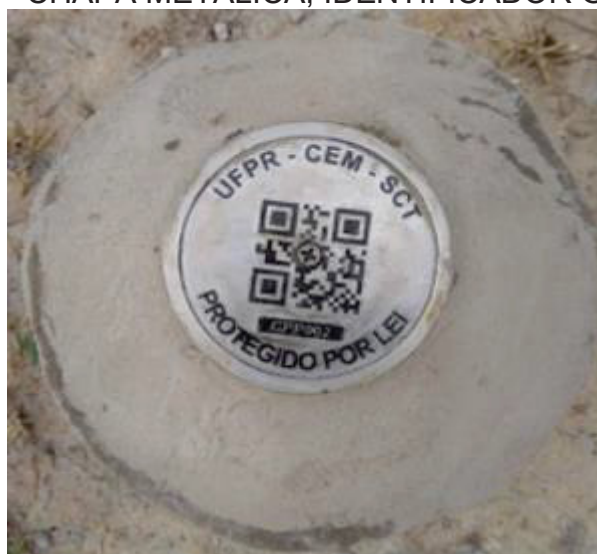
FIGURA 20 - CHAPA METÁLICA, IDENTIFICADOR GEODÉSICO.
