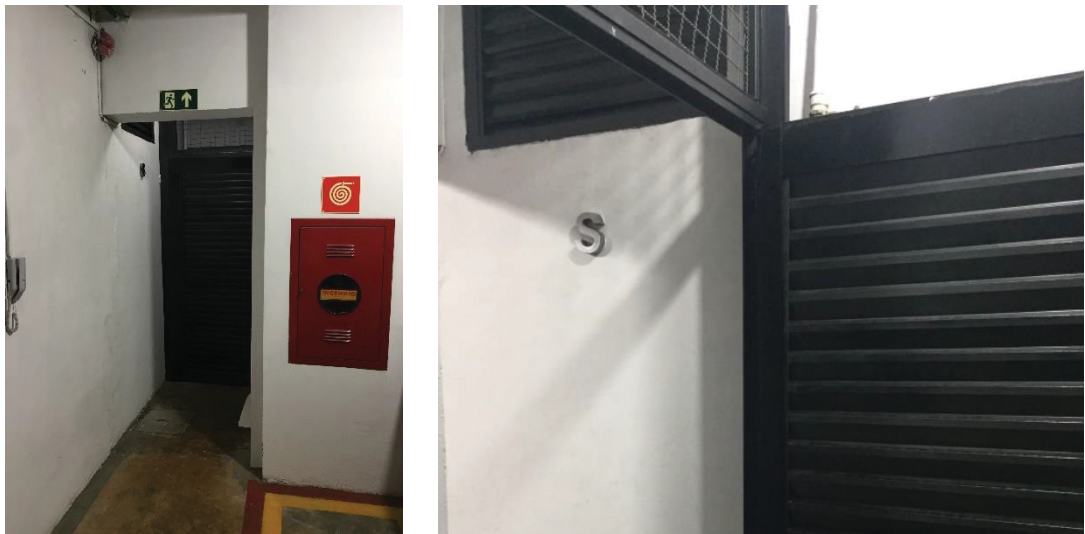
FIGURA 15 - Porta de acesso ao reservatório Inferior
