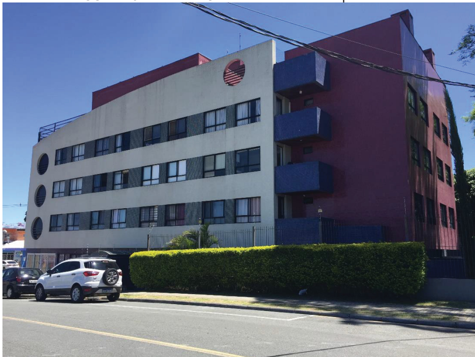
FIGURA 13 - Fachada Condomínio Edifício Aspen
