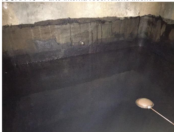
FIGURA 16 - Parte interna reservatório inferior
