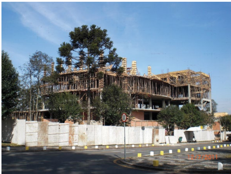
FIGURA 2 – SEDE DO SETOR DE CIÊNCIAS EXATAS, EM CONSTRUÇÃO (FOTOGRAFADA NO DIA 12 DE JULHO DE 2011)
