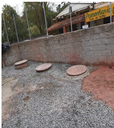
FIGURA 10 - CONSTRUÇÃO DA FOSSA BIODIGESTORA
