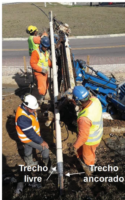
Figura 3.32 – Execução da monobarra tipo 2
