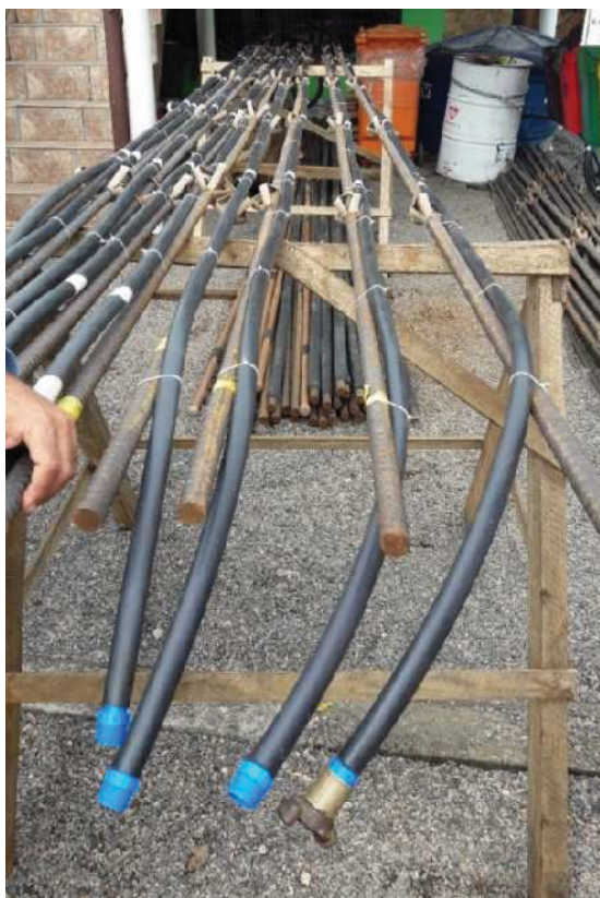
Figura 3.24 – Grampos com tubo de reinjeção
