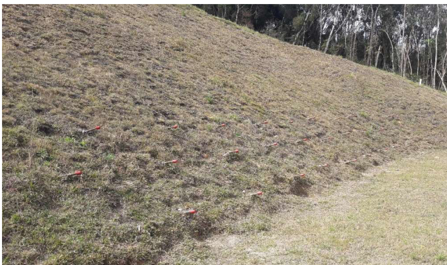
Figura 3.29 – Vista frontal do solo grampeado
