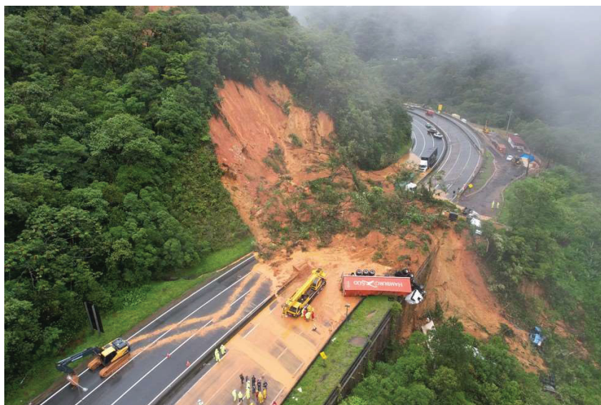
Figura 1.1 – Deslizamento de terra ocorrido na BR-376 em 2022
