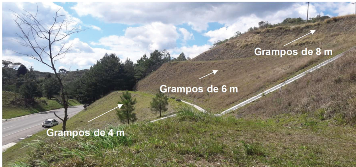
Figura 3.57 – Solo grampeado no km 658+400
