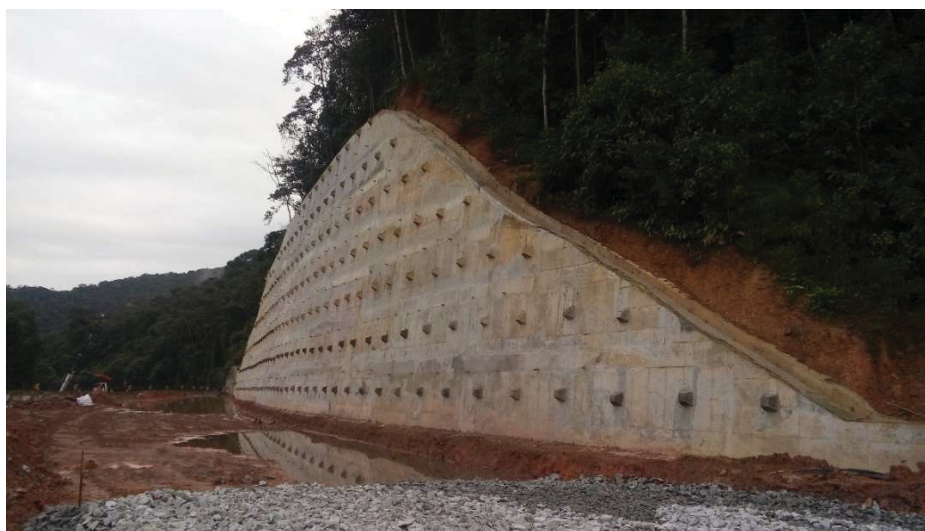
Figura 2.9 – Cortina atirantada em construção na BR-116
