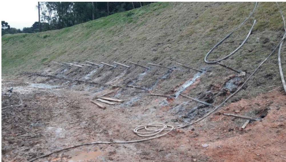
Figura 3.39 – Vista geral da cortina atirantada
