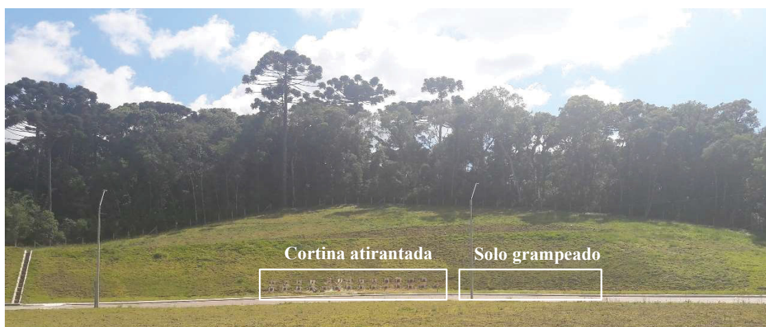
Figura 3.3 – Vista frontal da contenção experimental (2020)
