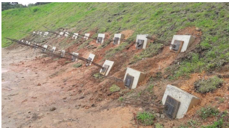
Figura 3.47 – Vista da área ao final da protensão dos tirantes
