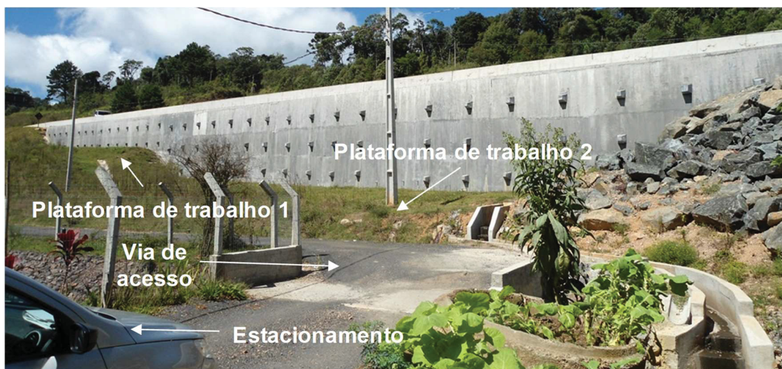
Figura 3.60 – Face da cortina atirantada avaliada
