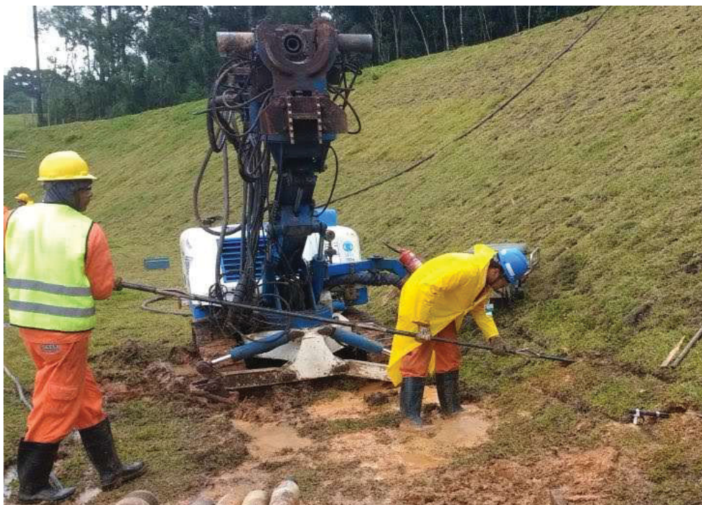
Figura 3.23 – Colocação do grampo dentro da perfuração
