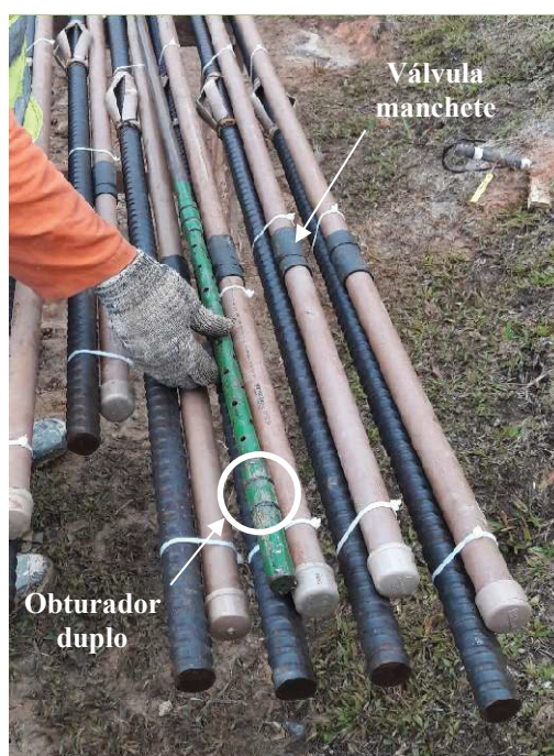
Figura 3.30 – Reinjeção dos tirantes
