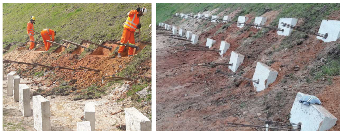
Figura 3.41 – Preparação do talude para colocação das placas de concreto
