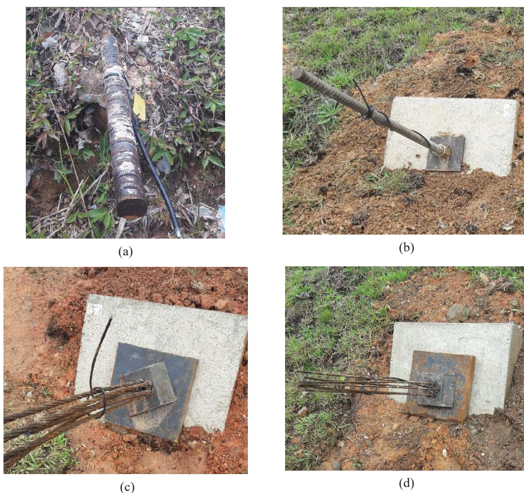
Figura 3.48 – Elementos da contenção experimental
