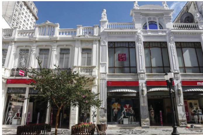
Figura 16 - Fachada da loja Marisa na Rua XV de Novembro em 2017
