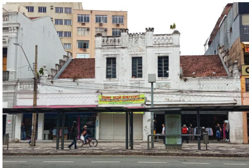
Figura 8 – Prédio atual da farmácia Stellfeld
