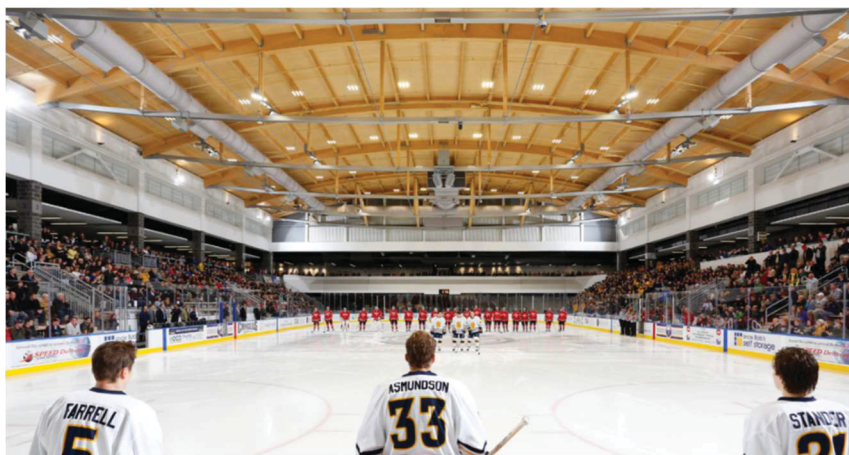
FIGURA 7 - COBERTURA EM MLC DO COMPLEXO HARBORCENTER, EM BUFFALO, NY
