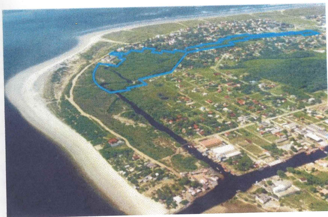
Figura 1. Fotografia aérea do Balneário de Pontal do Sul com a área de parque demarcada em azul
