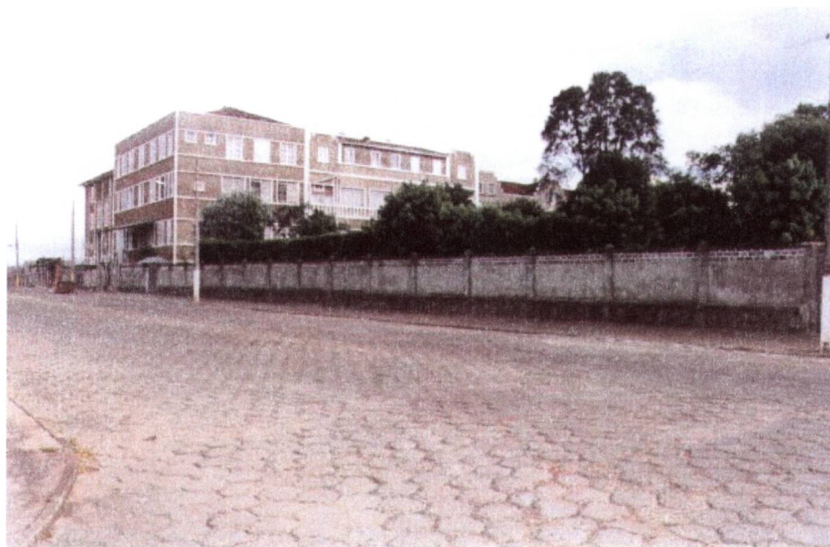
FIGURA 10 - TERCEIRO BLOCO DE ALVENARIA
