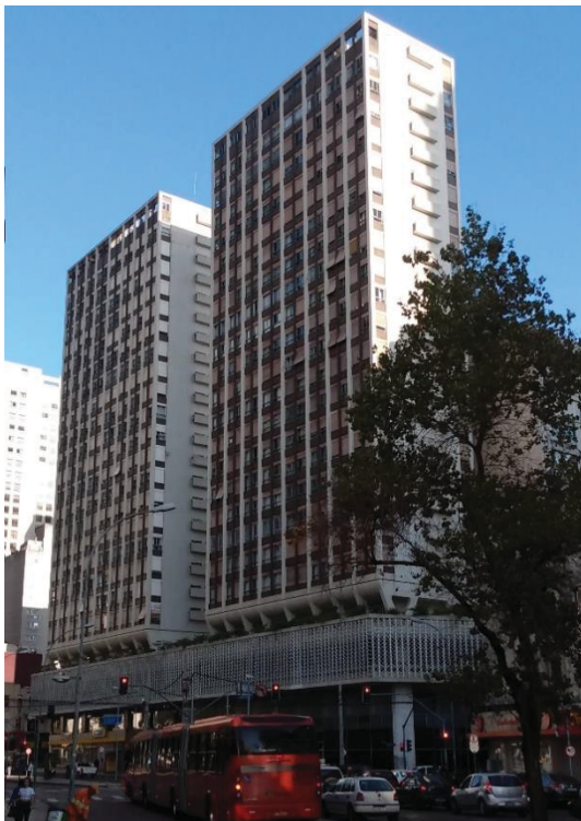
FIGURA 15 – EDIFÍCIO GEMINI, A PARTIR DA RUA VISCONDE DE NACAR
