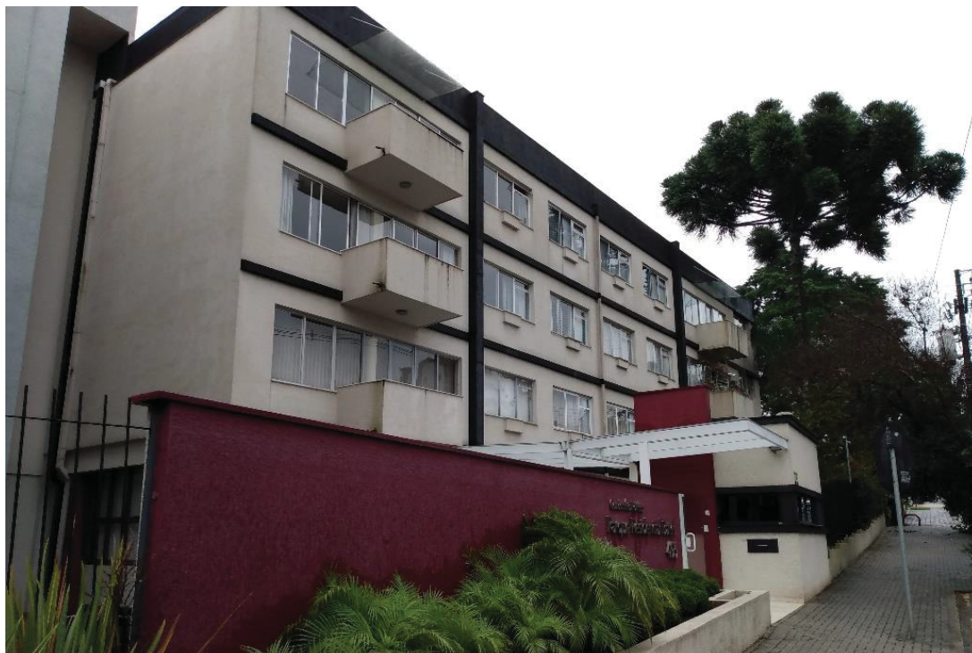
FIGURA 23 – EDIFÍCIO PARQUE RESIDENCIAL BATEL - FACHADA
