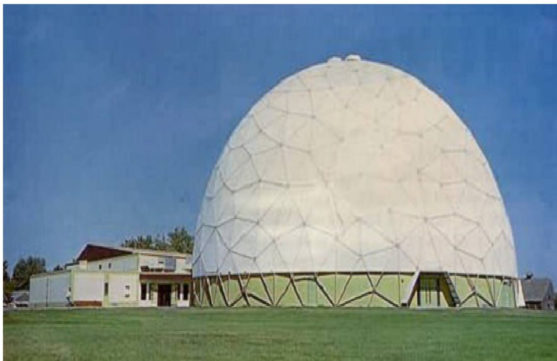
Figura 7 - radomo para proteção de antenas - ( www.radomes.org ) [27]
