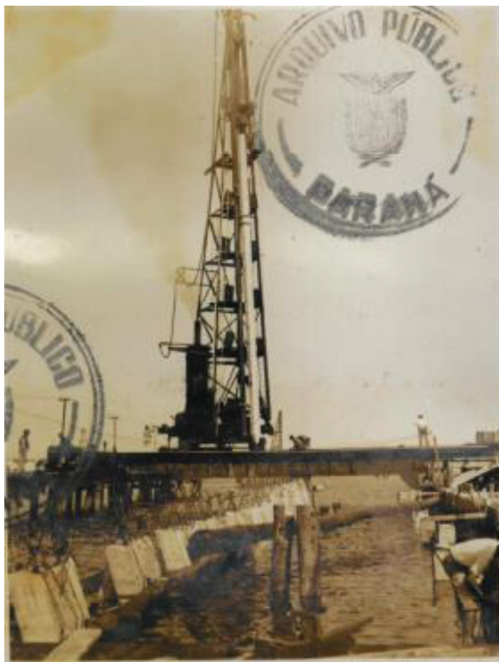
IMAGEM 19-ESTACAS DO CAIS EM CONSTRUÇÃO (1933).
