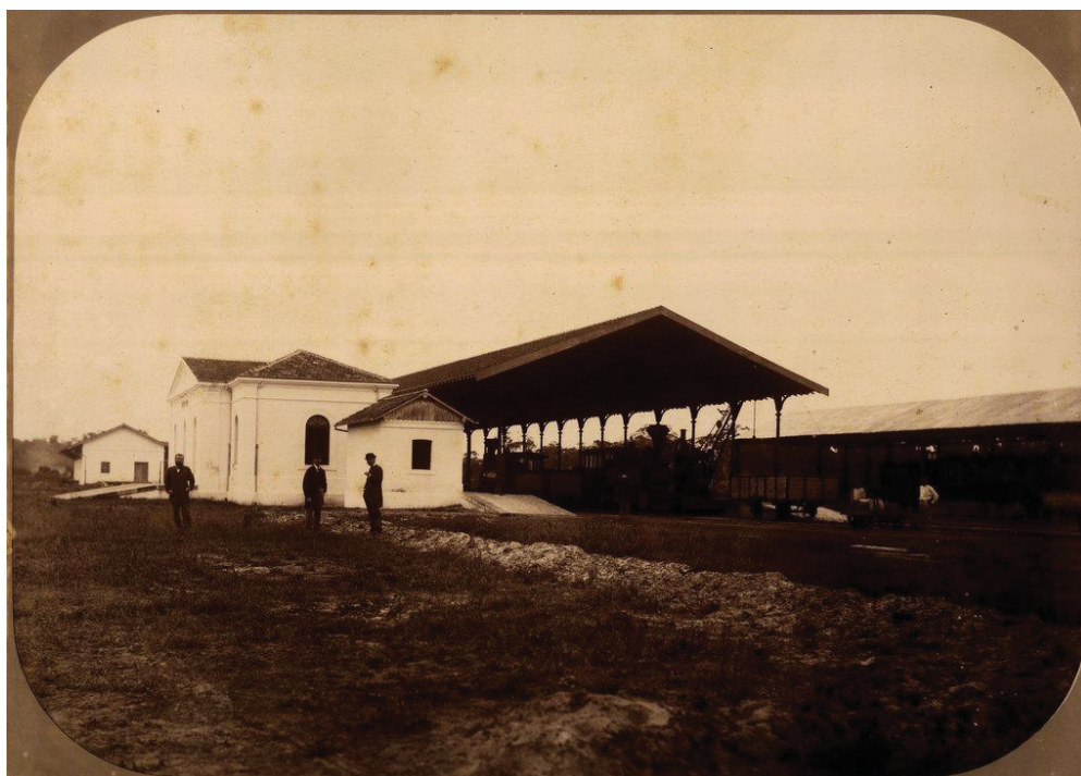
IMAGEM 14-ESTAÇÃO DO PORTO DOM PEDRO II (1885)
