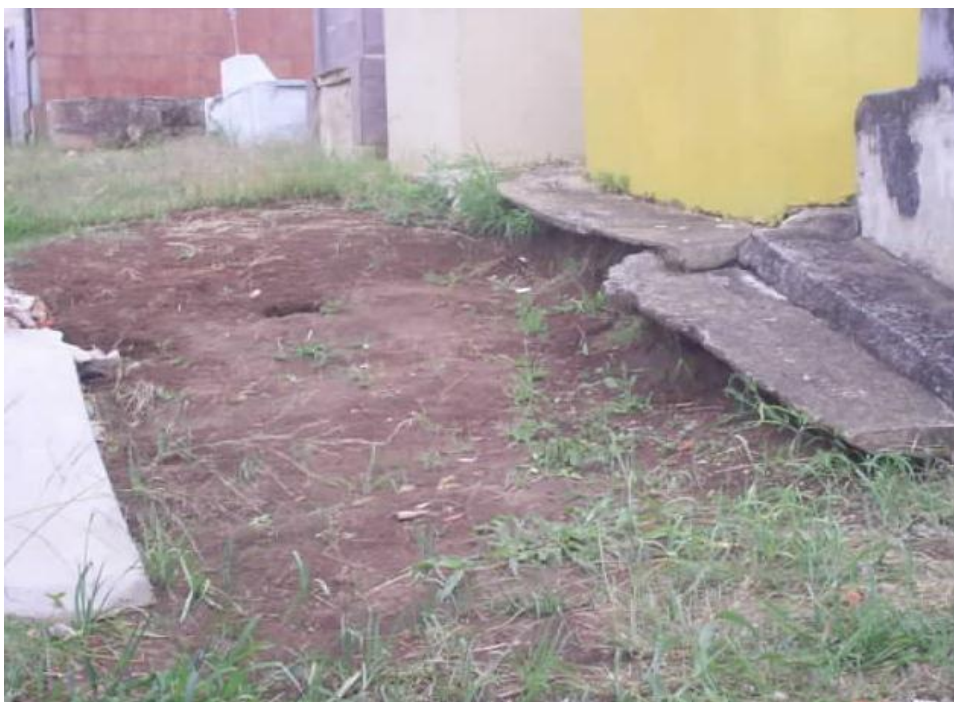
FIGURA 12 - EROSÃO LAMINAR
