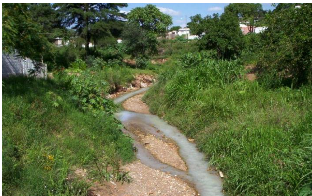
FIGURA 21 - ASSOREAMENTO DO LEITO FLUVIAL
