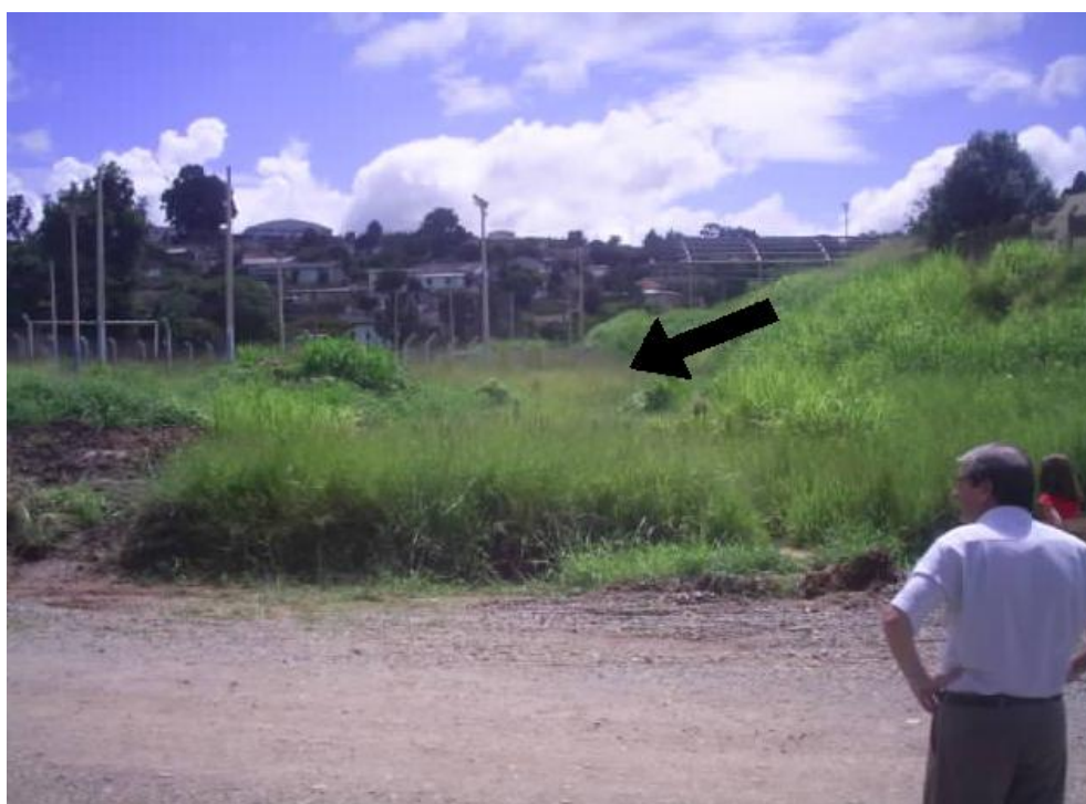
FIGURA 22 - TRECHO CANALIZADO DO ARROIO GERTRUDES
