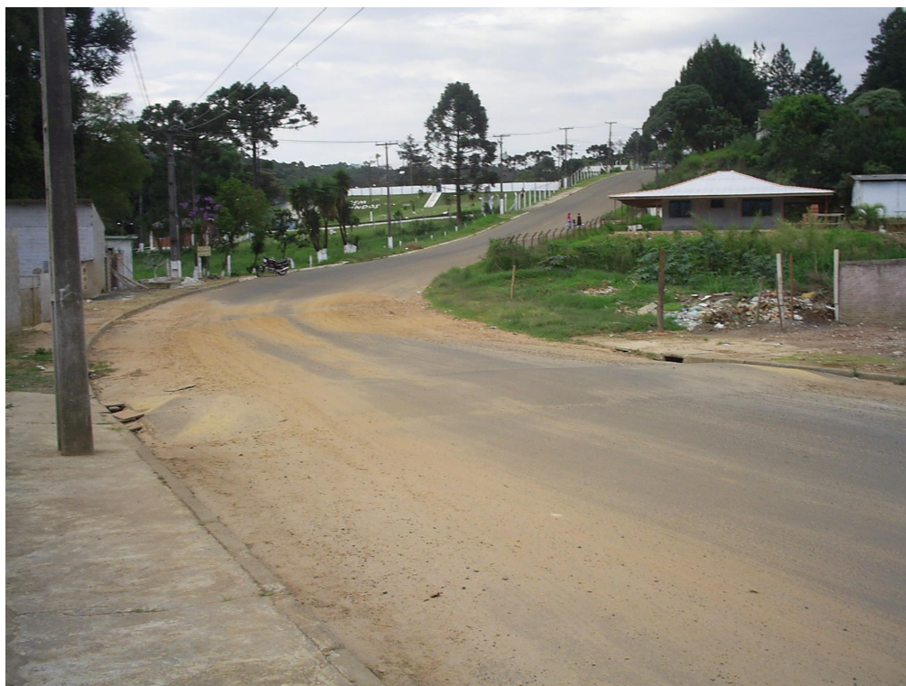
FIGURA 18 - TALUDE DE CORTE ASSOCIADO A TALUDE ARTIFICIAL
