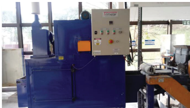
FIGURA 27 - TÚNEL DE SECAGEM DE PLACAS DE BATERIAS DE CHUMBO-ÁCIDO
