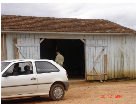
Oportunidade de melhorias: galpão utilizado para armazenamento de insumos, agrotóxicos e embalagens tríplice lavadas
