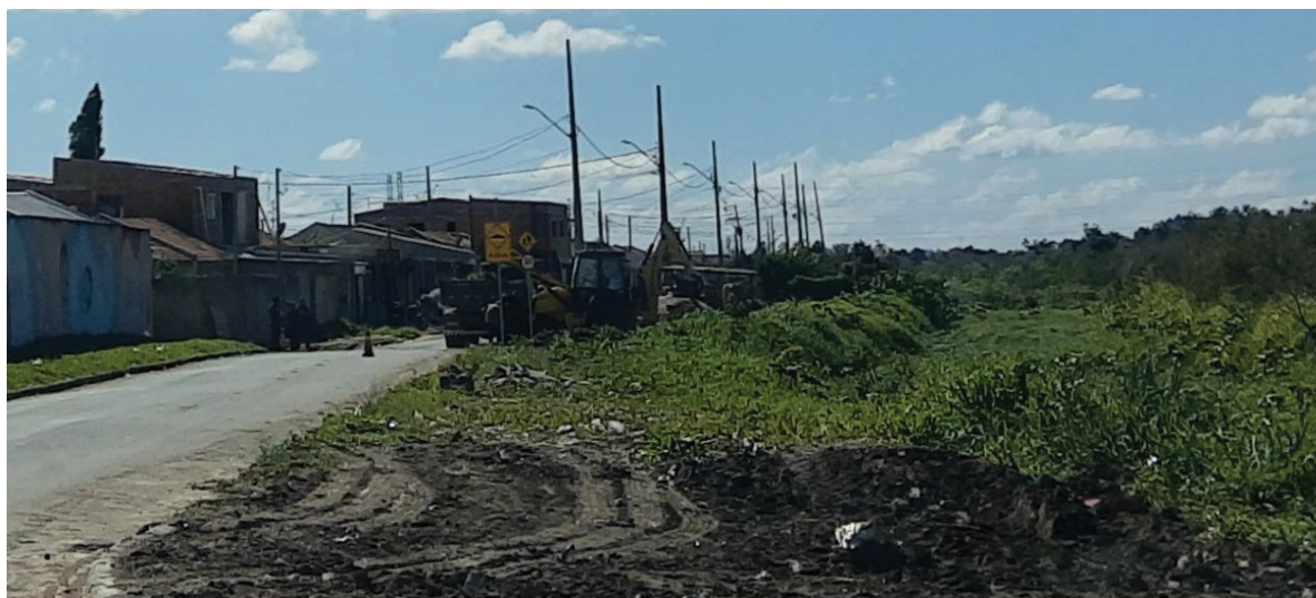
FIGURA 71 – OBRAS DE MANUTENÇÃO DO CANAL DE CONTENÇÃO DE CHEIAS – BOLSÃO AUDI UNIÃO – MUNICÍPIO DE CURITIBA - 2022
