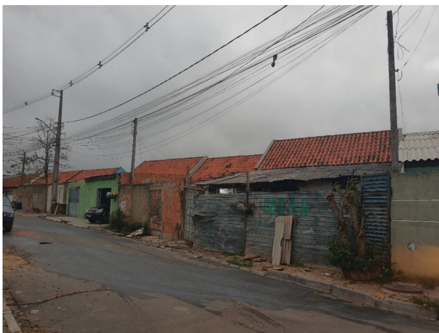
FIGURA 99 – CASAS DO MORÁDIAS LAGUNA COM OS MUROS FRONTAIS EXECUTADOS PELOS MORADORES – MUNICÍPIO DE CURITIBA – 2022
