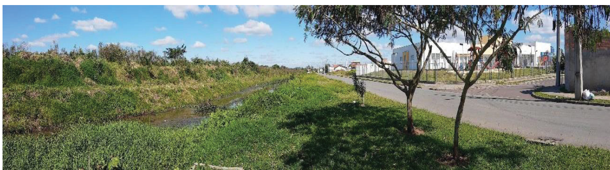
FIGURA 46 – CANAL DE CONTENÇÃO DE CHEIAS E CMEI – VILA AUDI UNIÃO – MUNICÍPIO DE CURITIBA – 2022
