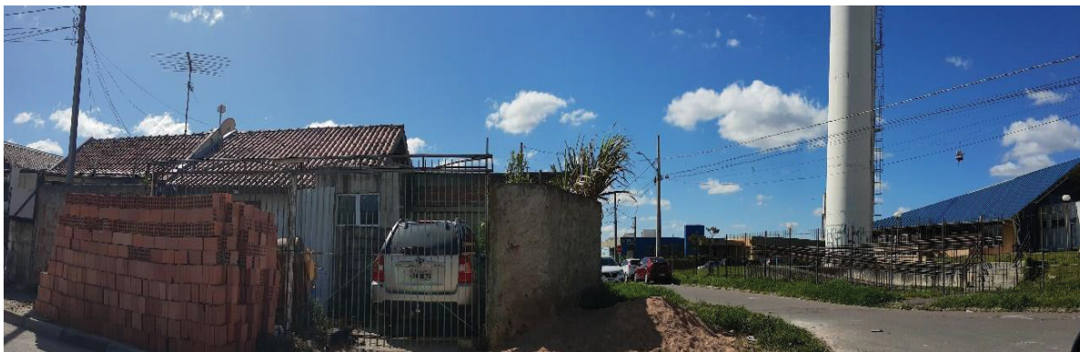
FIGURA 53 – VISTA HABITAÇÕES EM OBRAS E DO CMEI – VILA UNIÃO FERROVIÁRIA – MUNICÍPIO DE CURITIBA – 2022
