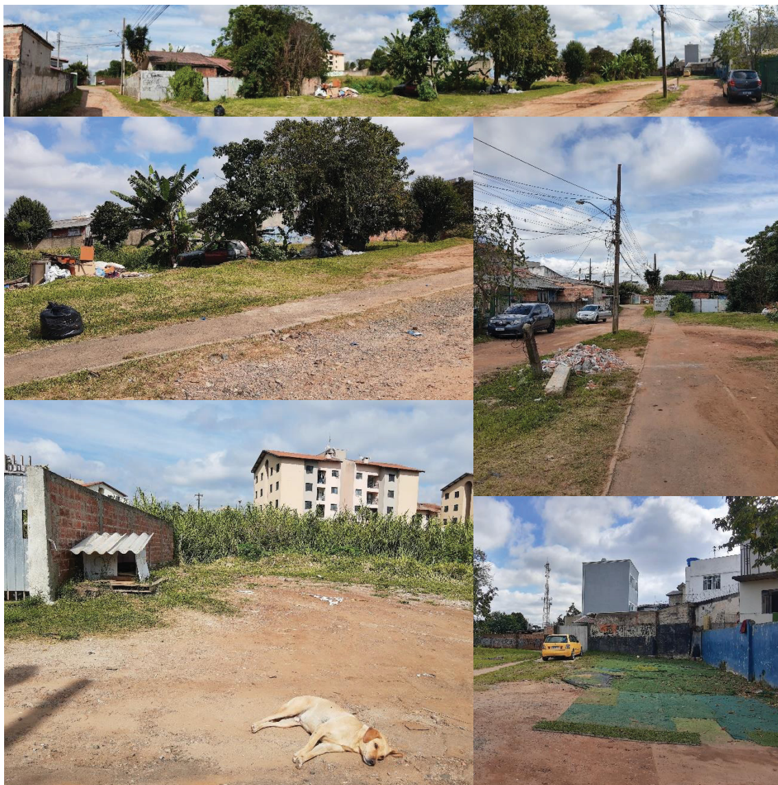
FIGURA 31 – CASA NÃO DEMOLIDA, APP SEM REQUALIFICAÇÃO VIA SEM PAVIMENTAÇÃO E CICLOVIA NA RUA FRANCISCO ADER - VILA FORMOSA – MUNICÍPIO DE CURITIBA - 2022
