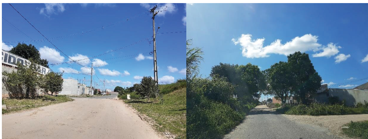
FIGURA 62 – INTERRUPTÃO DA DRENAGEM E DA PAVIMENTAÇÃO NA DIVISA ENTRE FAVELA E CONJUNTO HABITACIONAL – BOLSÃO AUDI UNIÃO – MUNICÍPIO DE CURITIBA – 2022
