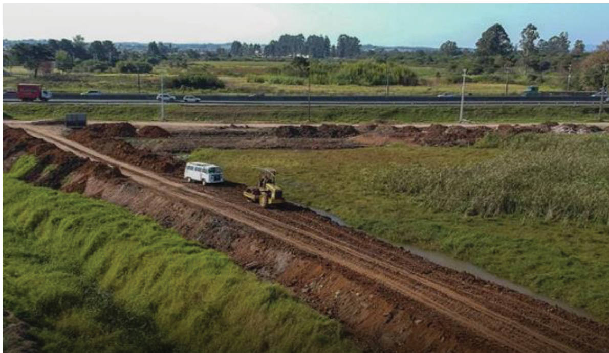
FIGURA 70 – CONTINUAÇÃO DA OBRA DO DIQUE DE CONTENÇÃO DE CHEIAS -NO ENTORNO DO BOLSÃO AUDI UNIÃO – MUNICÍPIO DE CURITIBA – 2022
