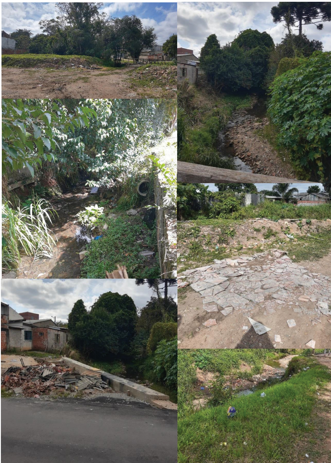
FIGURA 26 – FAIXAS DE APP COM ENTULHOS E RESQUÍCIOS DE CONSTRUÇÕES DEMOLIDAS, RIOS ASSOAREADOS E DETRITOS NOS RIOS – BOLSÃO FORMOSA – MUNICÍPIO DE CURITIBA - 2022
