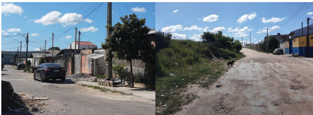
FIGURA 63 – FALTA DE INFRAESTRUTURA DE DRENAGEM NAS VIAS DA VILA UNIÃO FERROVIÁRIA – MUNICÍPIO DE CURITIBA – 2022
