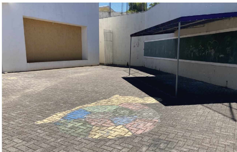
FIGURA 57 – ESTRUTURA CONSTRUÍDA DEVIDO À FALTA DE ÁREAS DE SOMBRA
