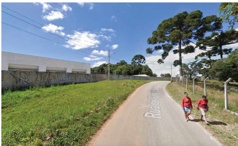
FIGURA 92 – MURO ENTRE A ESCOLA E A RUA, VISTO DA RUA
