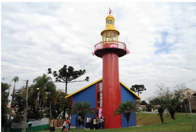
FIGURA 9 – FAROL DO SABER MACHADO DE ASSIS, O PRIMEIRO CONSTRUÍDO EM CURITIBA
