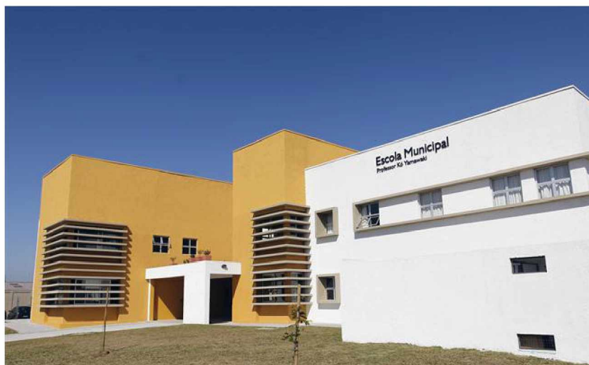
FIGURA 10 – EDIFÍCIO PADRÃO ATUAL, ESCOLA MUNICIPAL KO YAMAWAKI
