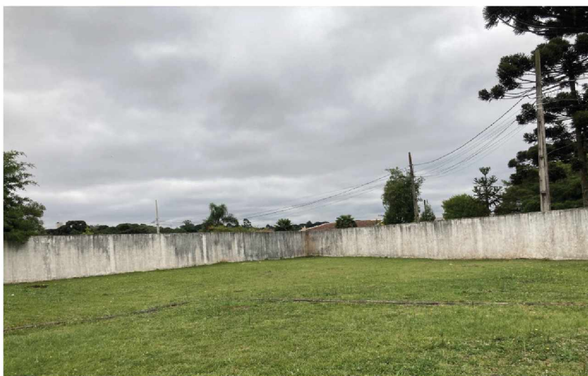
FIGURA 91 – MURO ENTRE A ESCOLA E A RUA, VISTO DA ESCOLA
