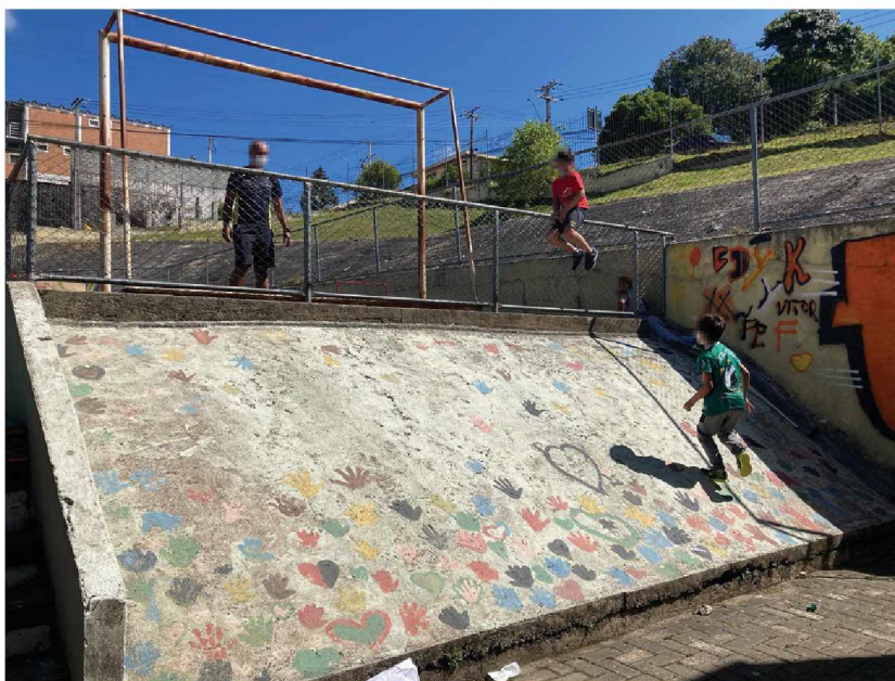
FIGURA 87 – PINTURA REALIZADA EM UM TALUDE DE CONCRETO
