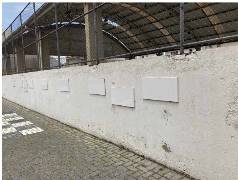
FIGURA 70 – AZULEJOS NAS PAREDES PARA PINTURA
