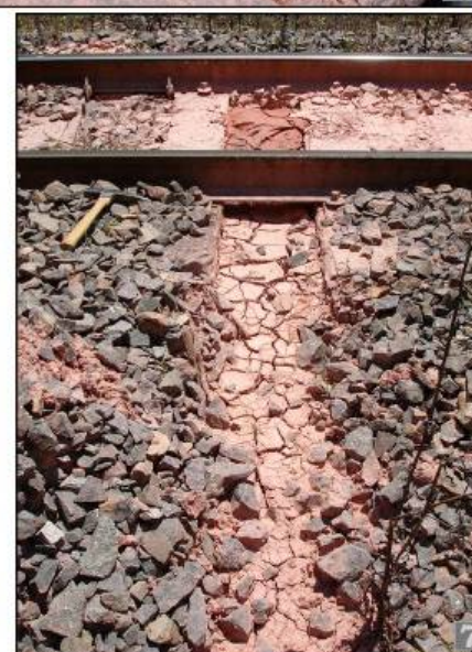
Foto 2: Primeiros respingos de lama sobre a camada de lastro; Foto 3: Área de aproximadamente 1m 2 afetado pelo processo; Foto 4: Área maior com lama na camada de lastro devido ao desenvolvimento do processo; Fotos 5: estrutura de extrusão de lama em forma de vulcão sobre a via férrea; Fotos 6: estrutura de extrusão de lama em forma de vulcão na lateral da via férrea; Foto 7: extravasamento de lama para a lateral da via férrea.
