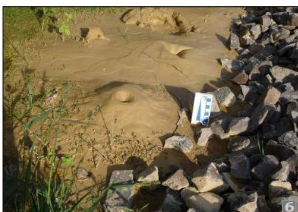
Foto 2: Primeiros respingos de lama sobre a camada de lastro; Foto 3: Área de aproximadamente 1m 2 afetado pelo processo; Foto 4: Área maior com lama na camada de lastro devido ao desenvolvimento do processo; Fotos 5: estrutura de extrusão de lama em forma de vulcão sobre a via férrea; Fotos 6: estrutura de extrusão de lama em forma de vulcão na lateral da via férrea; Foto 7: extravasamento de lama para a lateral da via férrea.
