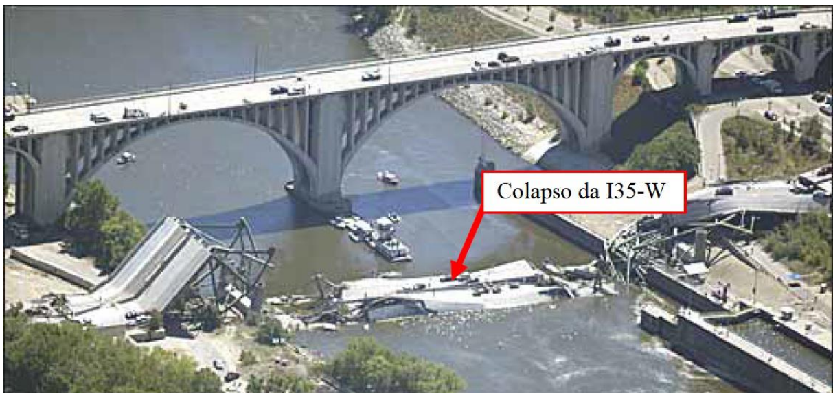
FIGURA 1 – COLAPSO PROGRESSIVO DA PONTE I35-W
