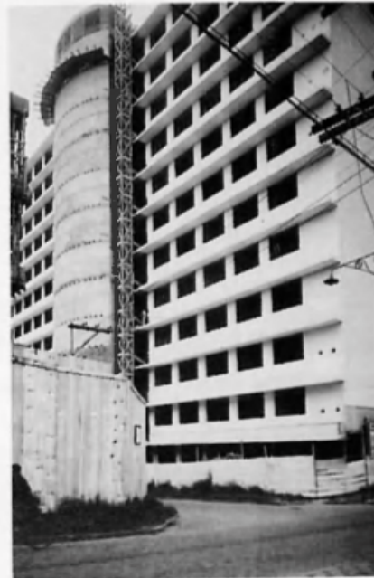
Obras do edifício D. Pedro I, vista da Rua Gal. Carneiro. Fonte: Biblioteca Central da UFPR.
