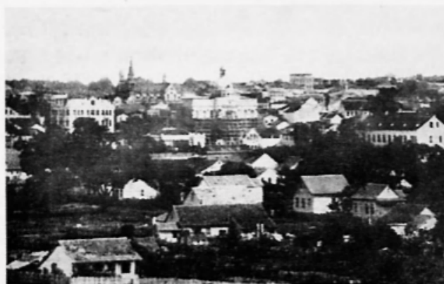
Vista de Curitiba com o prédio da Universidade em construção. Data provável, 1914. Fonte: UFPR 50 anos.
