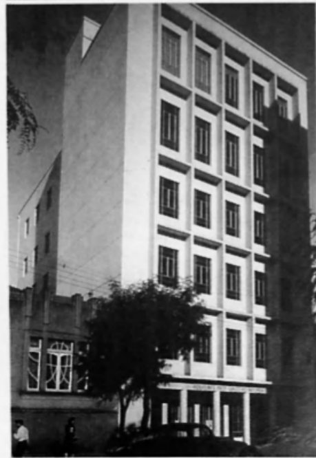
Policlínica Garcez do Nascimento recém-concluída.
