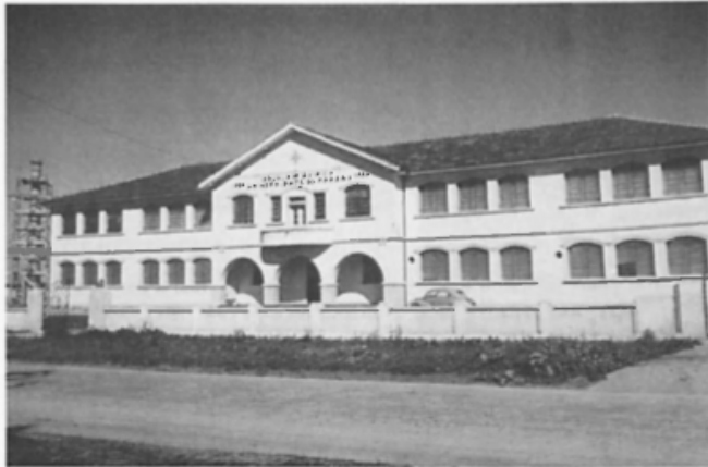
Edifício da Escola de Química na Rua Bom Jesus. Data provável: década de 50. Fonte: Biblioteca Central da UFPR.
