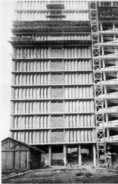
Obras do edifício D. Pedro I, vista do pátio da Reitoria. Fonte: Biblioteca Central da UFPR.
