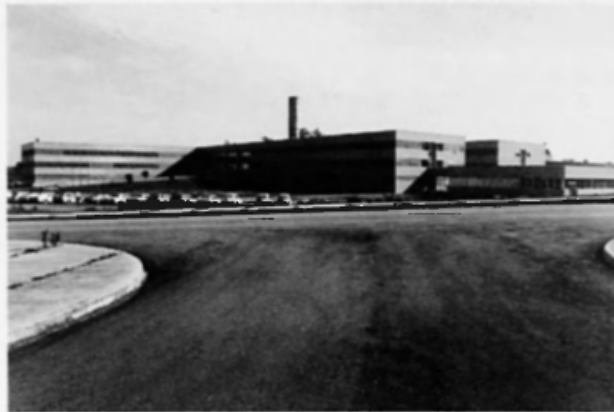
Vista aérea e terrestre do edifício do Setor de Ciências Biológicas no Centro Politécnico. Fonte: Arquivo da Prefeitura da Cidade Universitária da UFPR.
