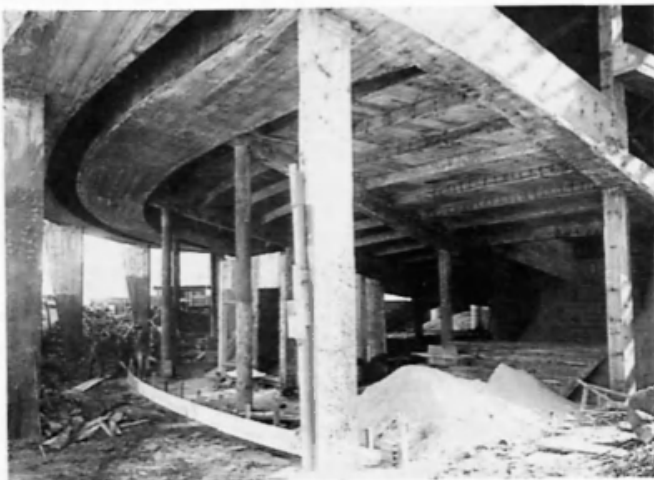
Obras de construção do auditório Fonte: Biblioteca Central da UFPR.
