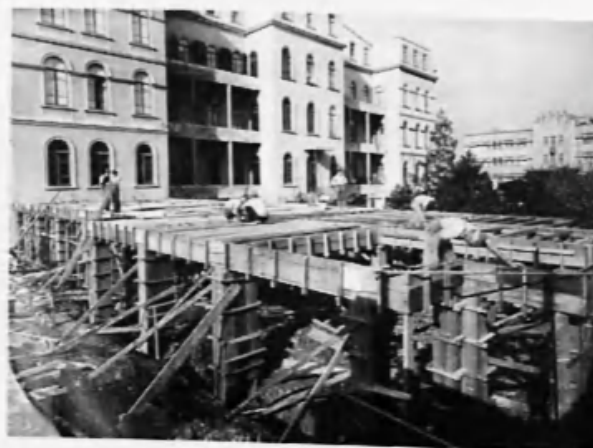
Construção da ala da Escola de Engenharia. Fonte: Revista Técnica do DAEP, 1947.
