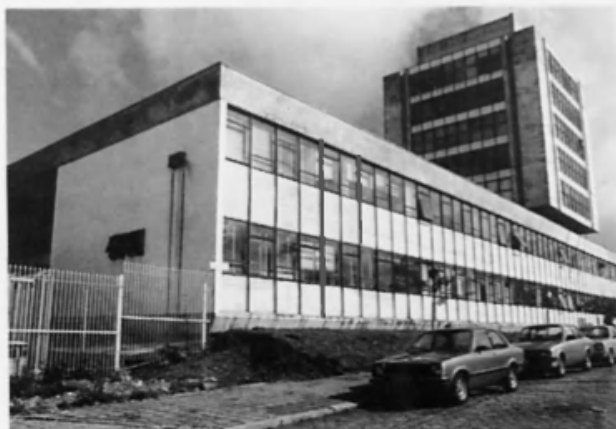
Bloco didático do Setor de Ciências da Saúde. quando concluído.
