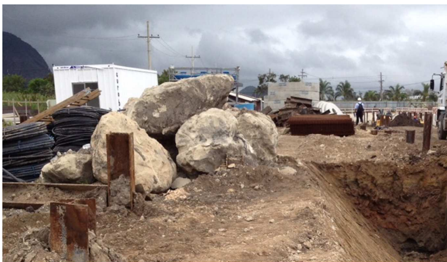
FIGURA 16 - FORMAS DOS BULBOS APÓS ESCAVAÇÃO
