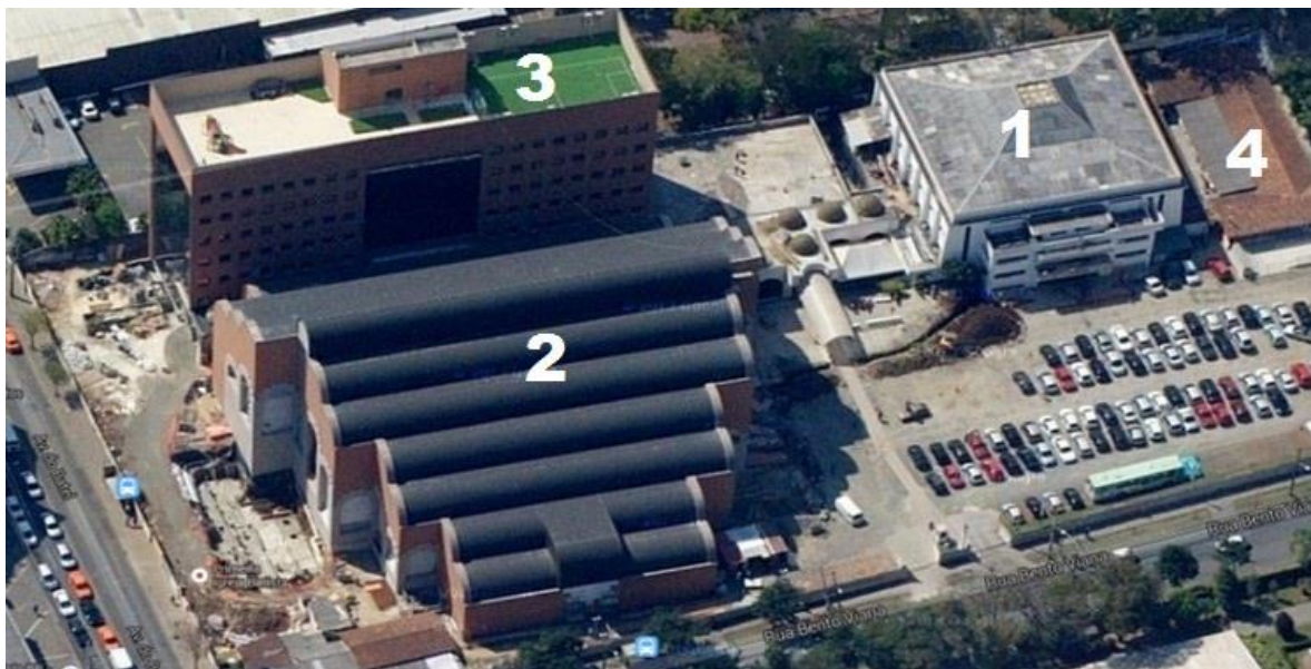
Figura 4 - Vista aérea da PIB Curitiba. Fonte: Google Earth.
