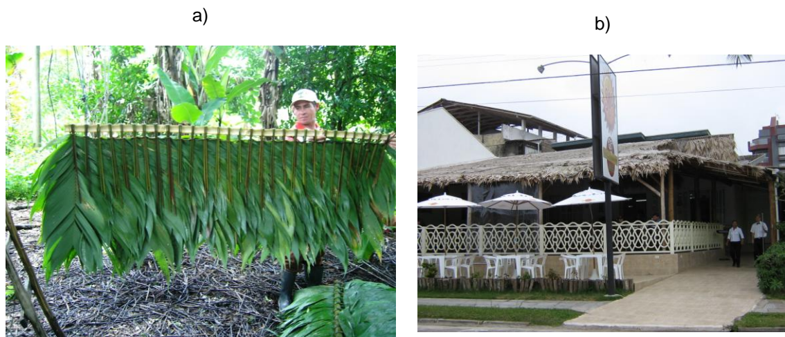
FIGURA 1. 4 – DETALHE DA ESTEIRA DE FOLHAS DE PALHA PARA COBERTURA (a) E RESTAURANTE COBERTO COM FOLHAS DE Geonoma gamiova (b) EM GUARATUBA-PR (Fotos: Ceccon - Valente, M. F., Guaratuba-PR, 2008)
