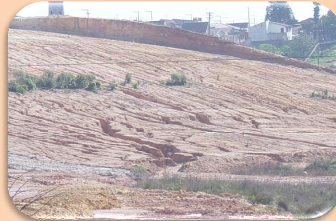
**Figura 16.** Loteamento no bairro Atuba em Curitiba (PR), no qual ocorreu erosão após decapitação dos horizontes superficiais do solo. Na parte superior da imagem se observa a altura original do solo. Na parte inferior da imagem há o soterramento da várzea do rio Atuba. Foto: Nerilde Favaretto.
